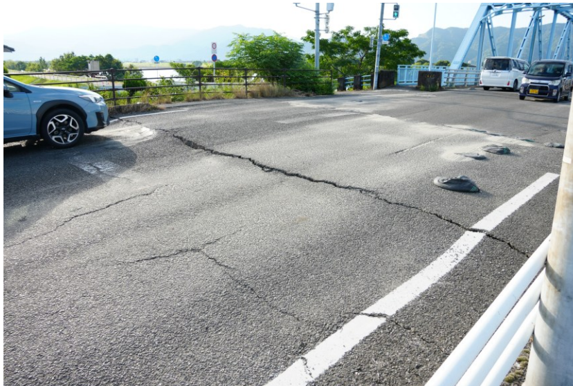
アプローチ部 (北側 8月1日)
