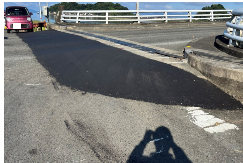
【損傷箇所の応急復旧】
