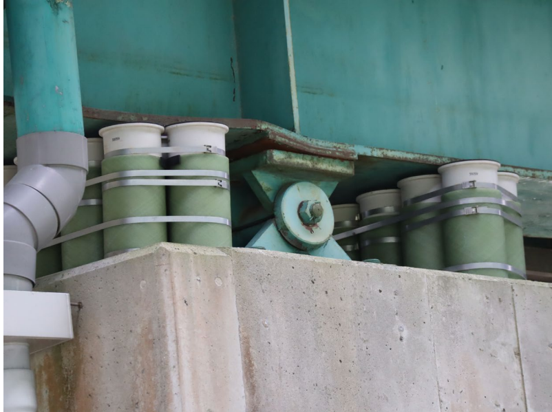
P3橋脚支承
