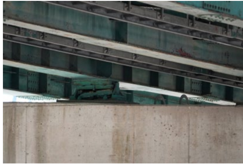
P2橋脚支承
