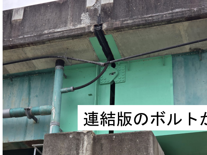
P4橋脚（掛け違い部）
