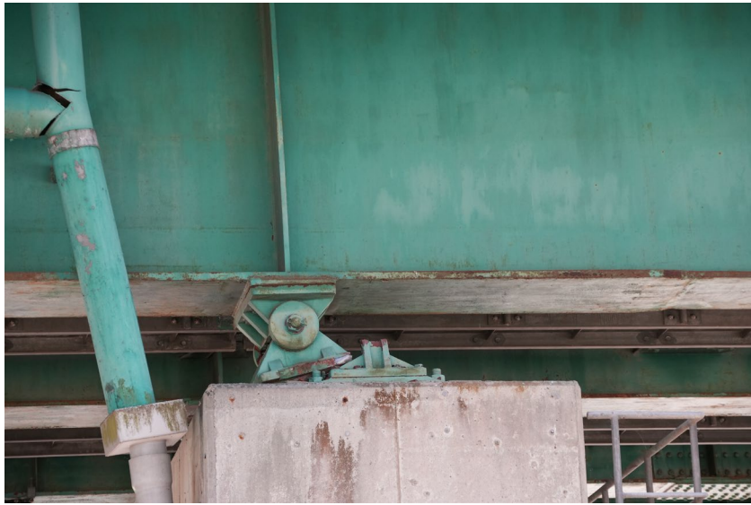
P1橋脚支承
