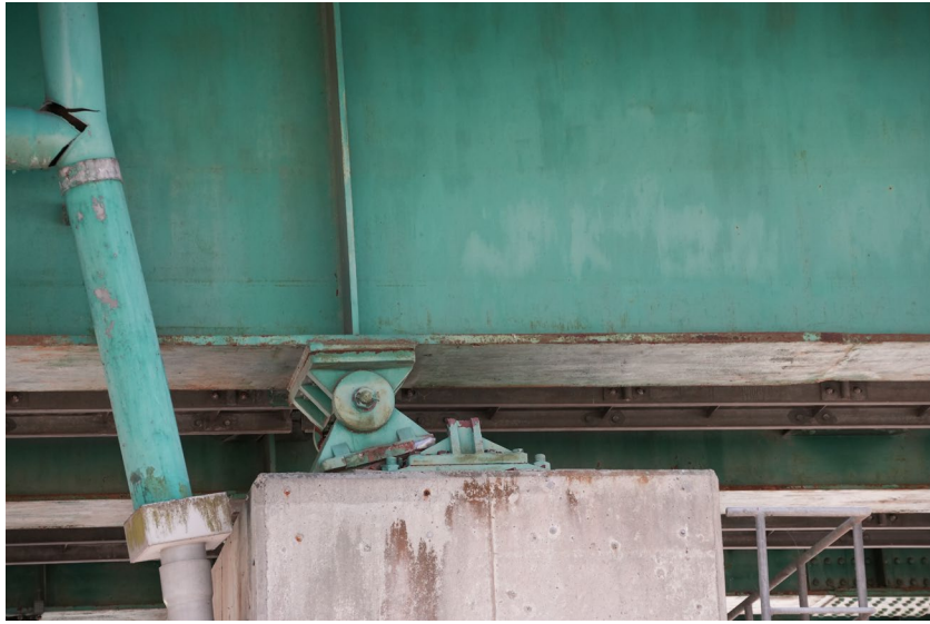
P1橋脚支承
