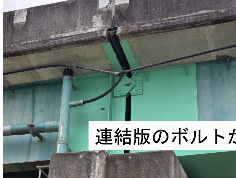
P4橋脚（掛け違い部）
