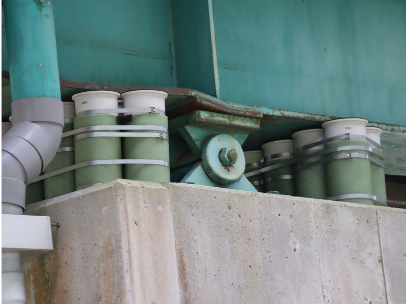
P3橋脚支承
