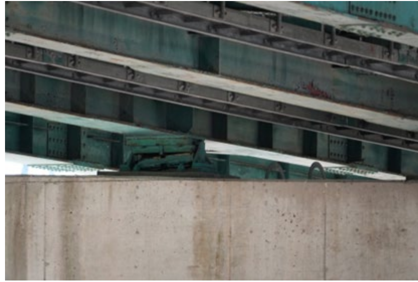
P2橋脚支承
