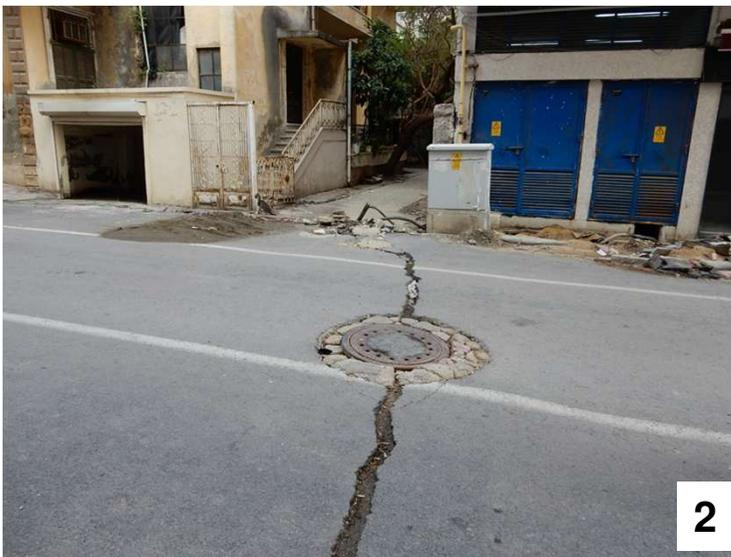
1. 海岸沿い：舗装と建物1Fの床にわずかな段差、舗装のめり込みや亀裂
