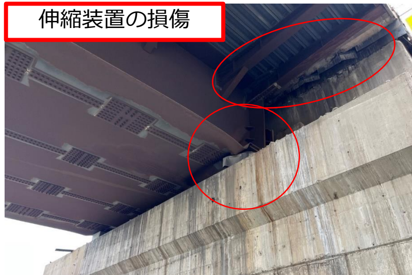
鋼桁の下フランジ部の座屈
