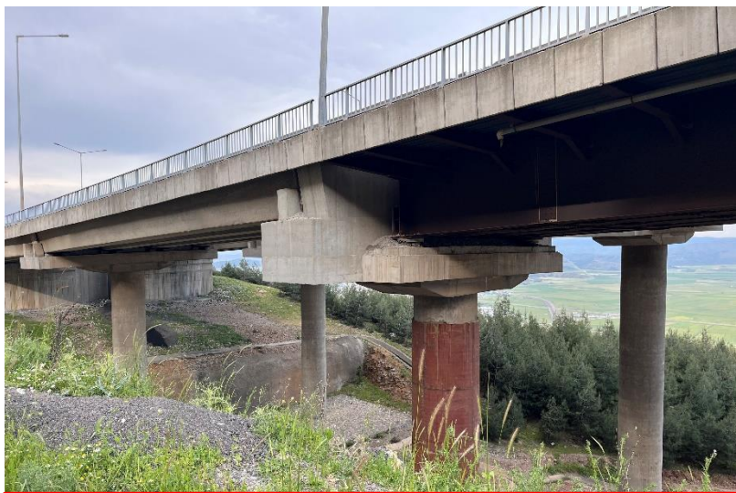
掛け違い部 : 鋼板巻立による措置
