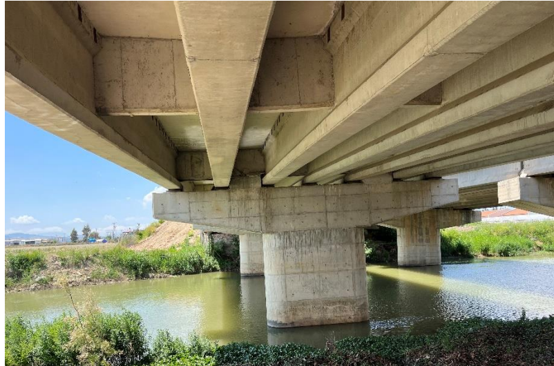
主桁・橋脚（通行可）
