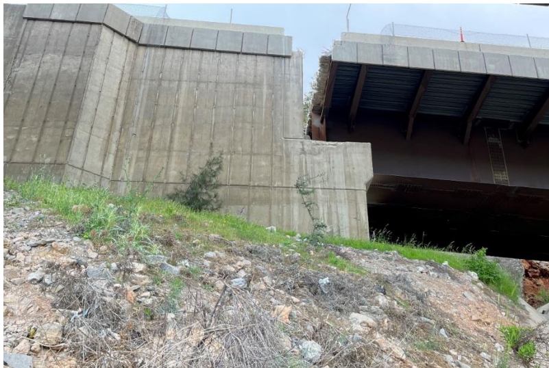
主桁-橋台間の離隔
