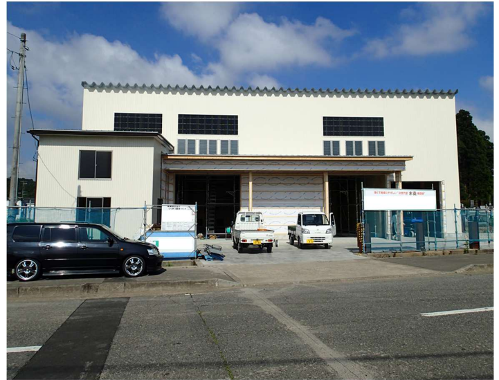
農舎の建設状況
