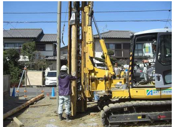
戸建て住宅（浦安市美浜3丁目）
