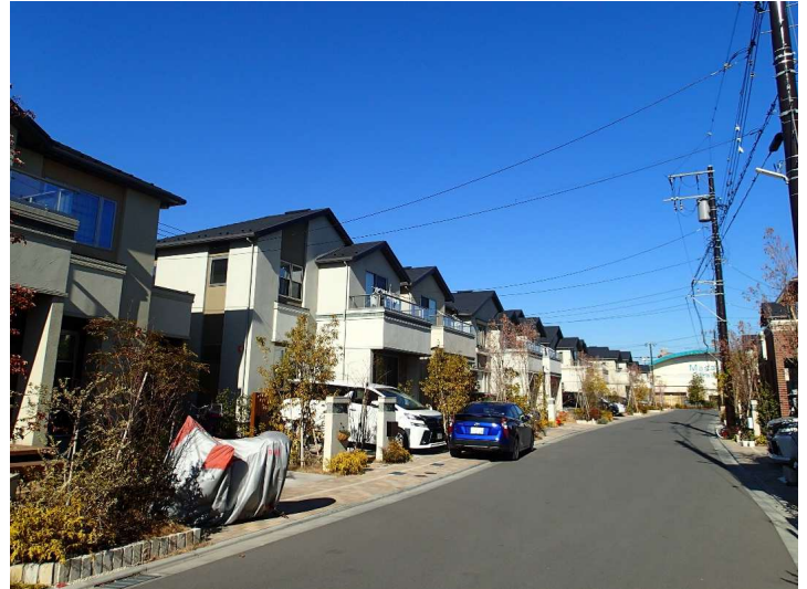
完成後の状況
