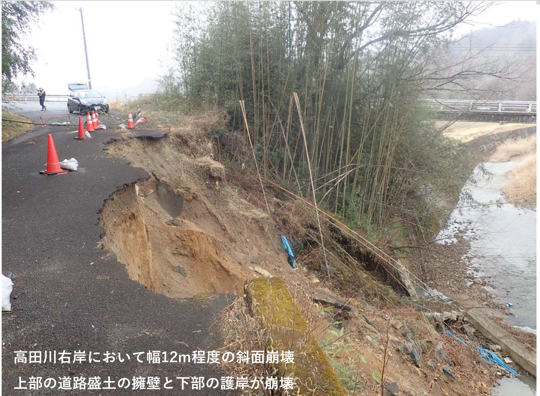
高田川右岸において幅12m程度の斜面崩壊
