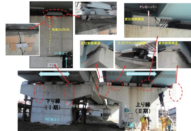
図-3 P5 橋脚の損傷状況
