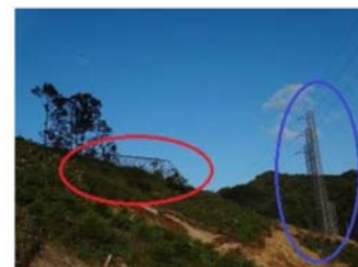
倒壊した送電鉄塔【左】と鉄柱による仮復旧の状況【右】（むかわ町）
