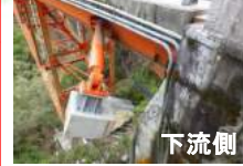
A2橋台側 ダンパー取付け部
