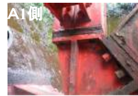
アーチ支点のボルトの破断
