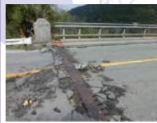
A2橋台ジョイント部
