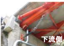
A1橋台側 ダンパー取付け部
