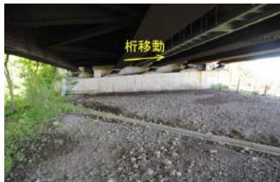
橋軸直角方向への桁移動
