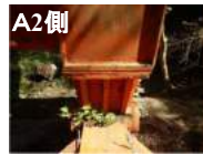
アーチ支点のボルトの破断
