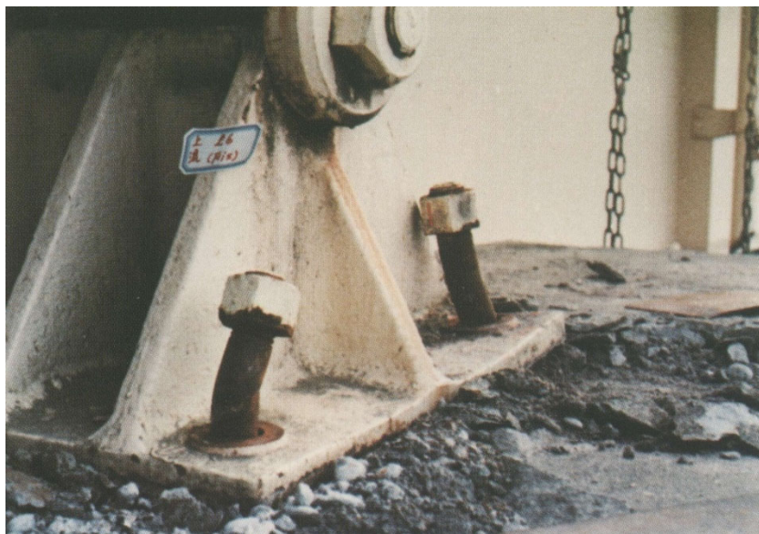
ピン支承の実損傷例： アンカーボルトの抜け出し
