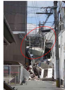
[熊本市内] 建物倒壊に伴う2次被害
