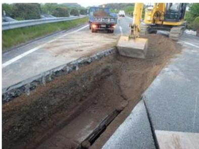
目地部の開きが拡大し、路面の影響が発生した箇所の対応
