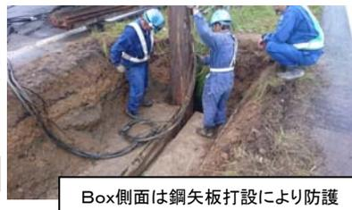
Box側面は鋼矢板打設により防護
