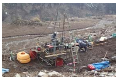
地質調査状況
