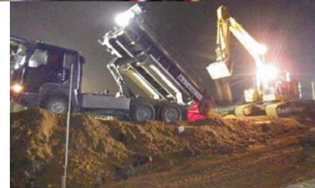
早期復旧のため 24時間態勢で施工 10
