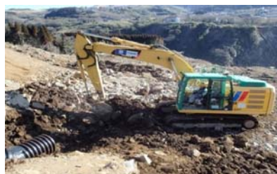
排水工の整備状況
