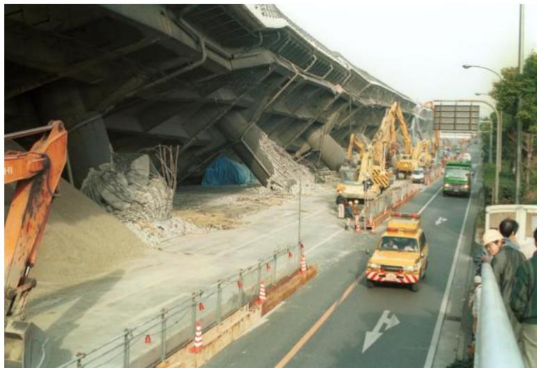
ロッキング橋脚を有する跨道橋の落橋による
