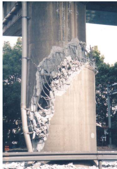
鉄筋コンクリート橋脚の曲げ挙動
