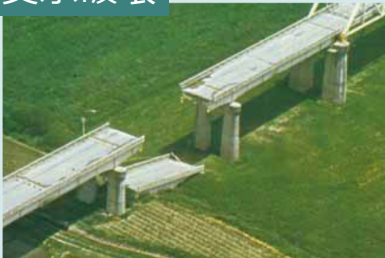
1978年宮城県沖地震 | 昭和大橋
