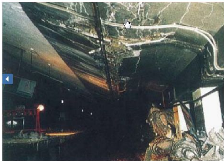
図7) 阪神・淡路大震災後の地下鉄大開駅の被害状況 (出典：阪神・淡路大震災調査報告書 土木学会)
