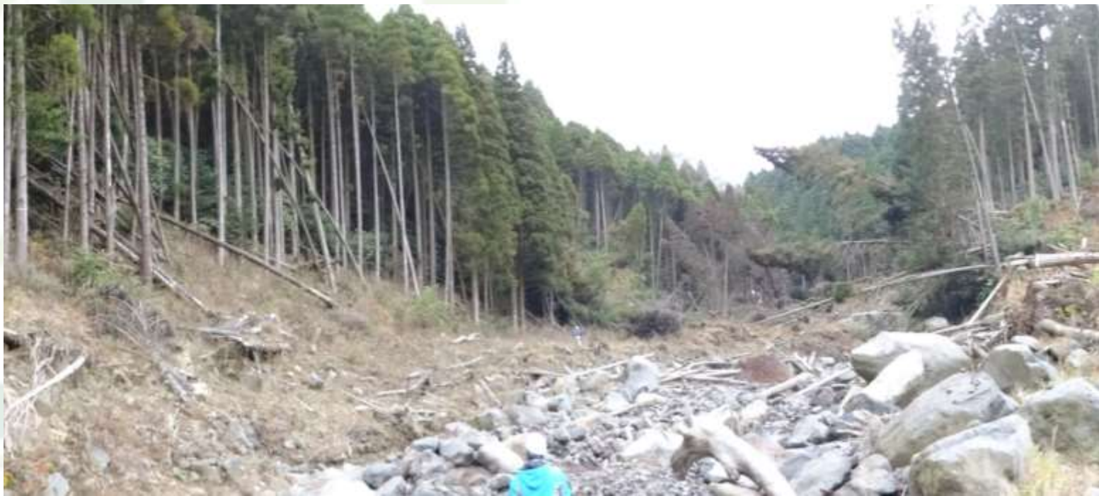
山王谷川砂防堰堤堆砂状況(2017/12/10撮影)
