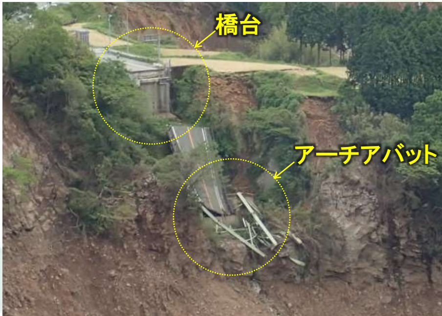
図3.1-11 左:左岸側橋台とアーチアバット, 右:右岸側橋脚とアーチアバット
