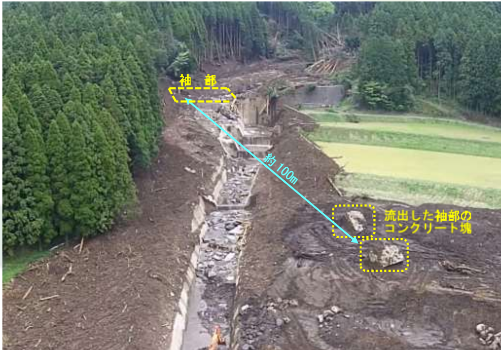
写真3.1-19 山王谷川砂防堰堤の被災状況と下流流路工内の巨石堆積状況
