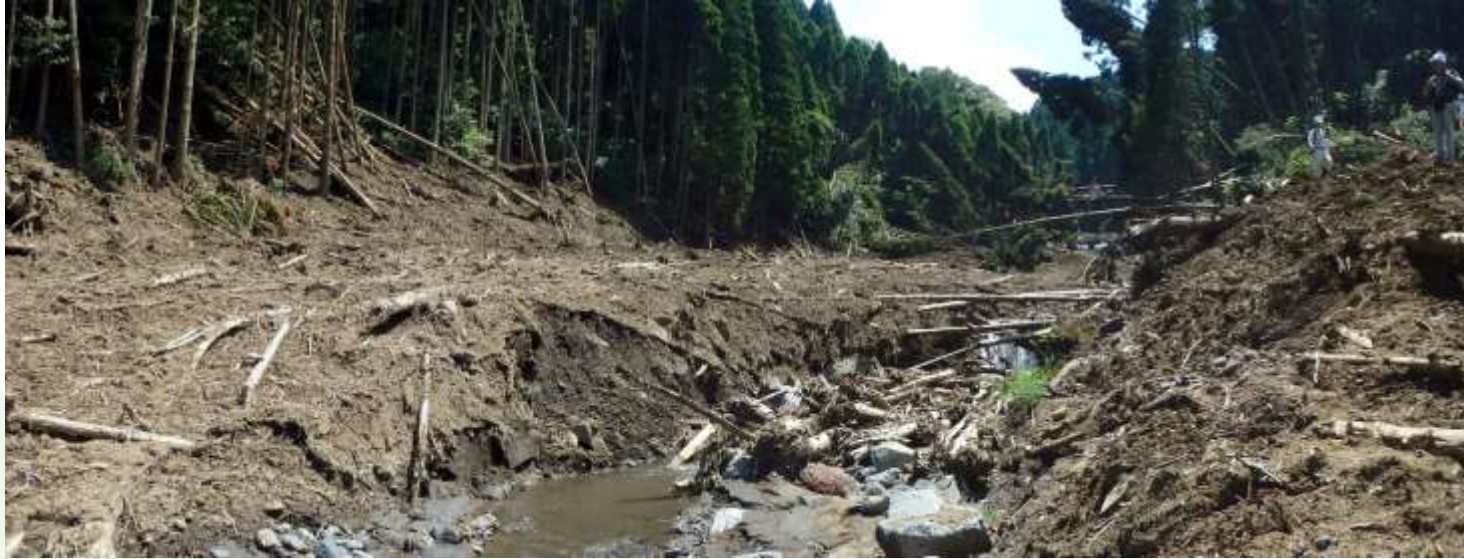
写真3.1-24 山王谷川砂防堰堤堆砂状況(2016/6/3撮影)
