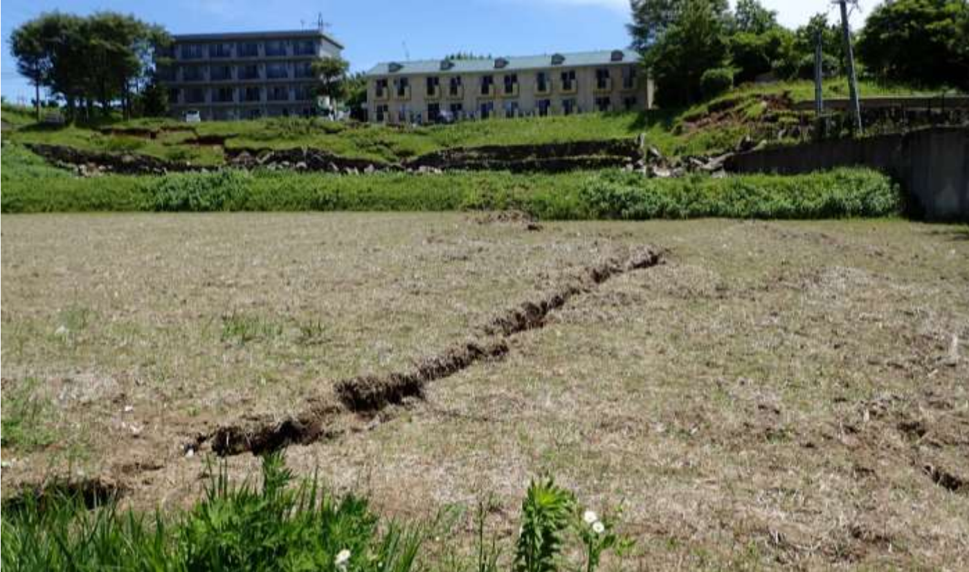
図3.1-12 河陽地区に認められた地表地震断層
