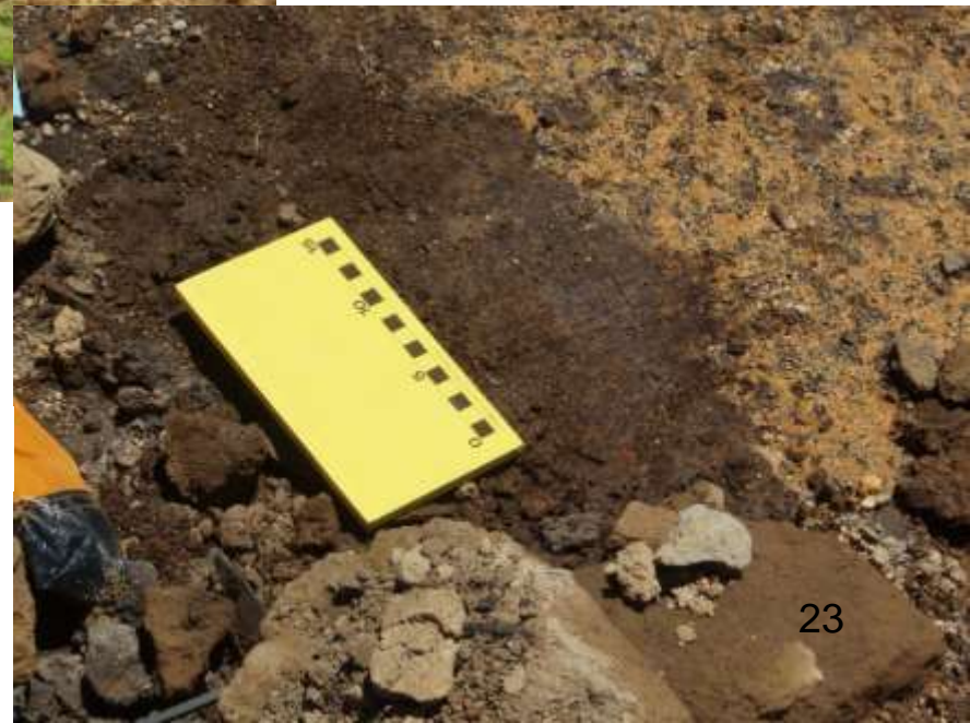
写真3.1-6(b) 崩壊部の底部 に露出したすべり面
