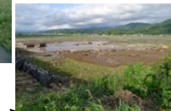
氾濫後の堤内 6月23日17時頃
