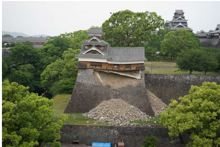
(a) 飯田丸五階櫓の被害状況
