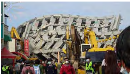
維冠金龍大樓16階
