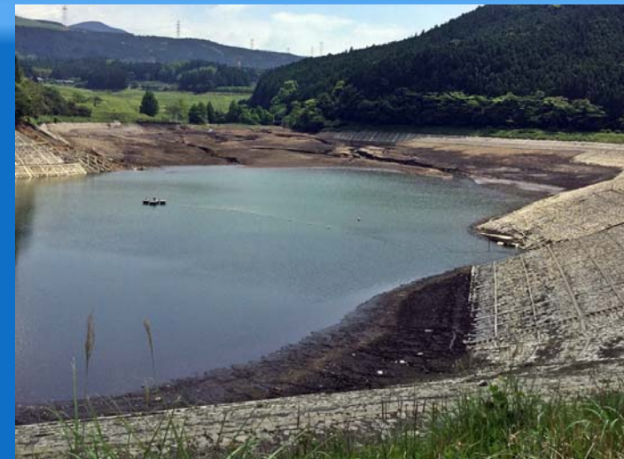
ダム全景(水位低下後)
