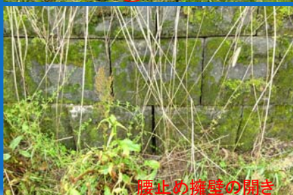
崩壊部付近は堤体がはらみだす
