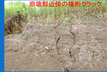
崩壊部近傍の縦断・横断クラック
