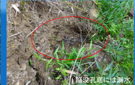
陥没孔の漏水は下流法尻へ続く
