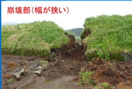
池側から見た崩壊部
