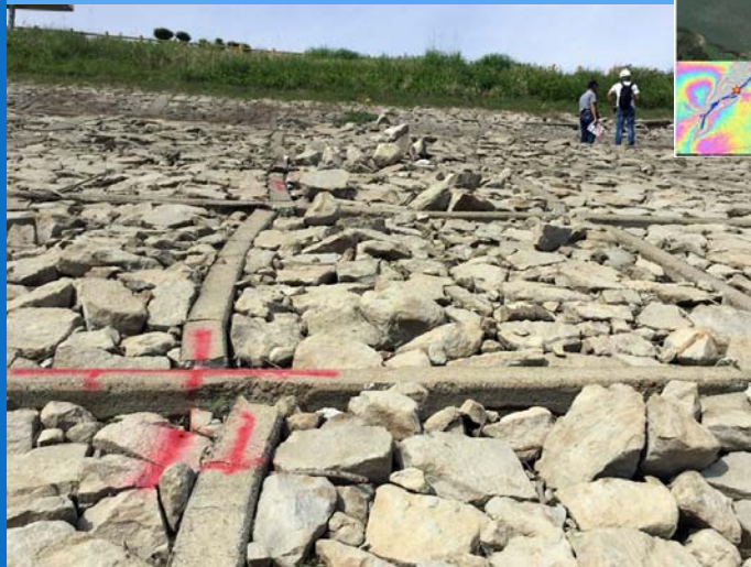
堤体内法の敷石と法枠護岸の変状
