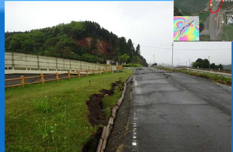
堤体天端の縦断・横断クラックと沈下
