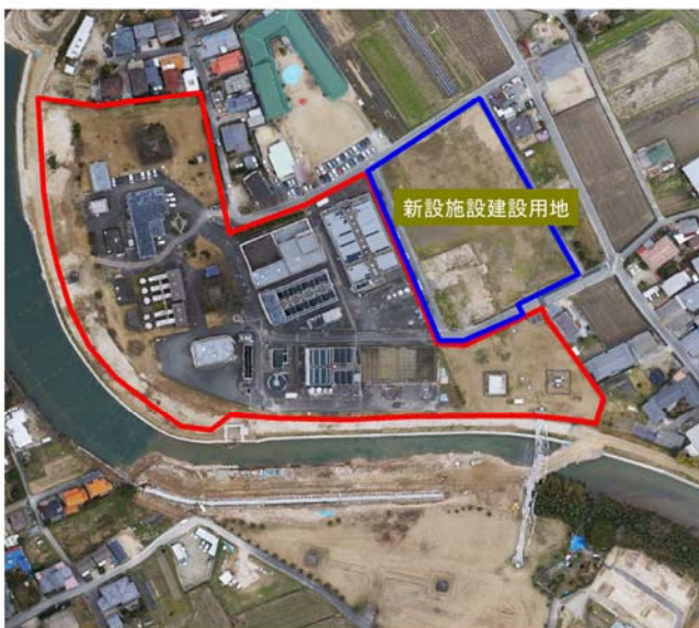
着工前 (平成25年7月)
