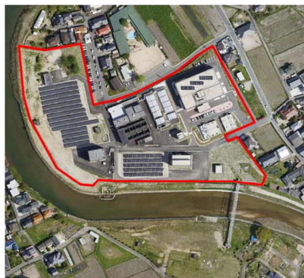
竣工後 (平成30年3月)
