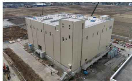
建設が進む高度浄水処理棟 (HPより)
