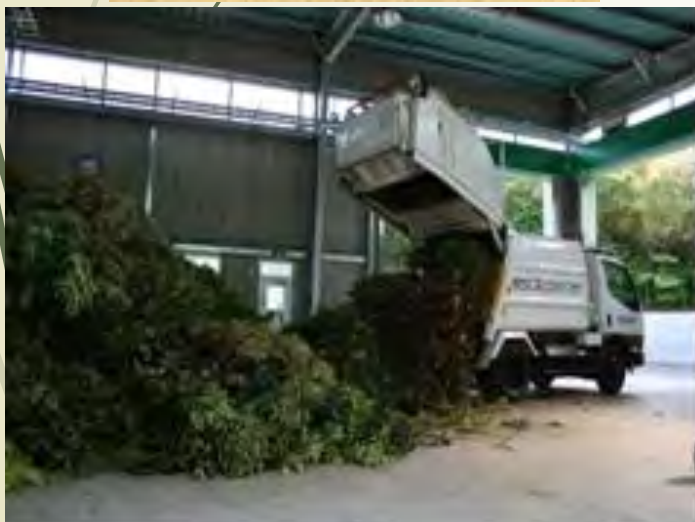
受入貯留ヤード
