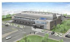
東京都瑞江葬儀所 火葬炉10基 建設中
