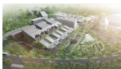
シンガポールニューマンダイ火葬場 火葬炉9基 建設中
