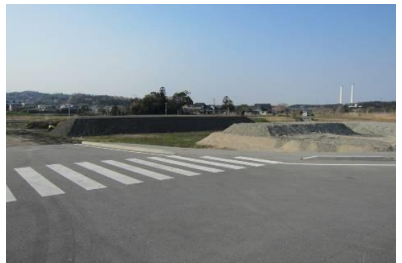
写真③ 海岸沿いに造成中の防災緑地(50m幅)。写真手前側が海岸につながる。
