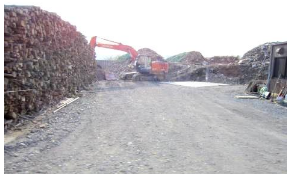
写真⑤ 瓦礫置場の廃棄木材
