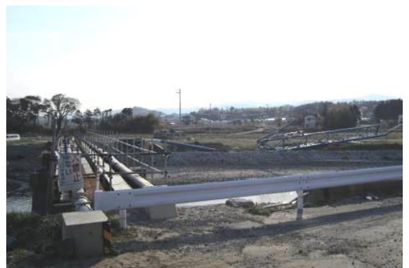
写真④ 仮設の下水水管橋。対岸には被災した元の水管橋が見える。
