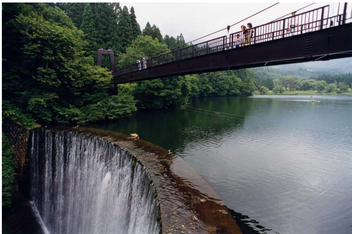
大源太川第 1 号砂防堰堤
