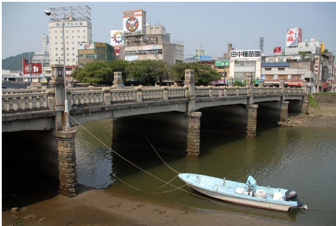
被爆に耐えた装飾的橋梁—猿猴橋・京橋
