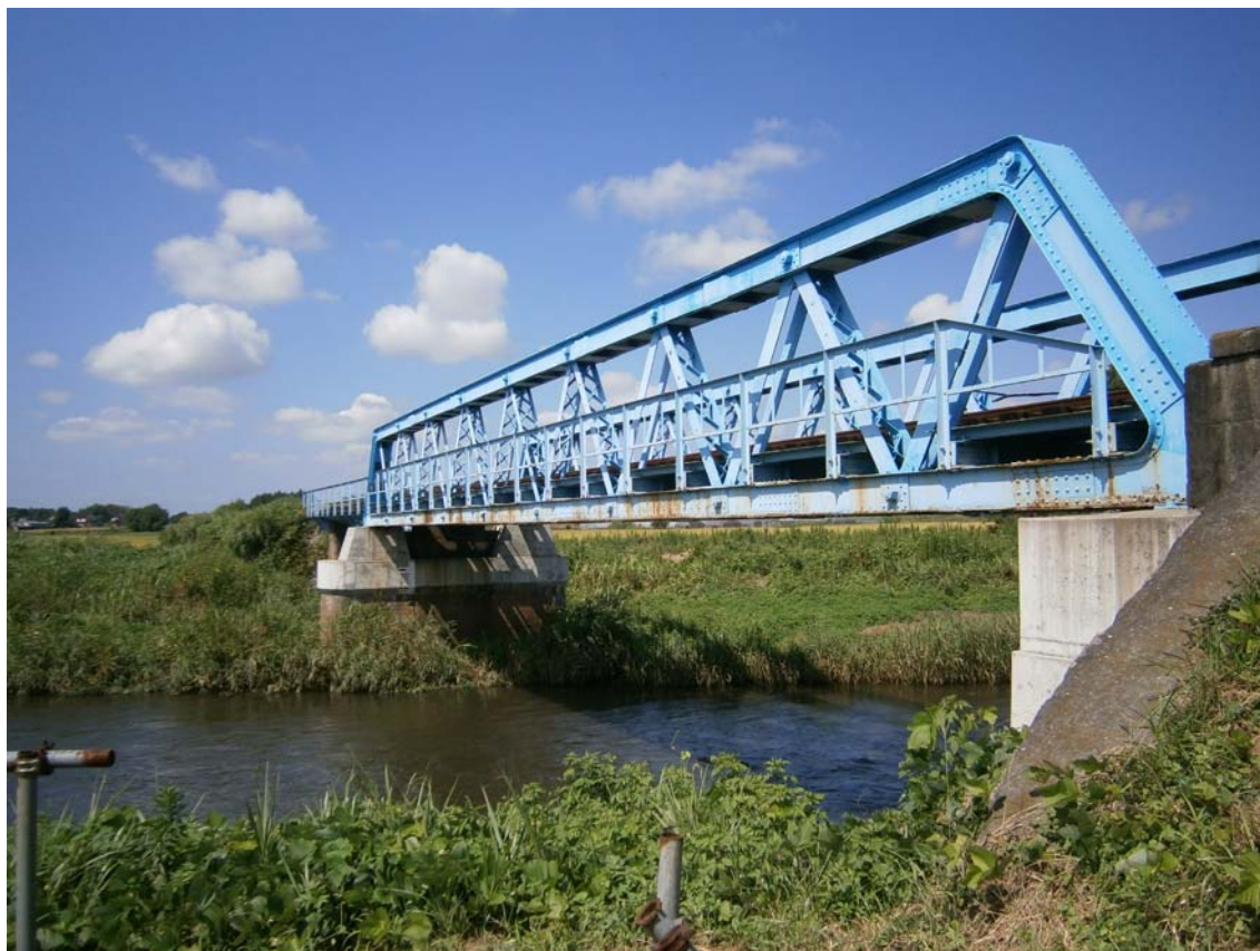
真岡鐵道五行川橋梁・小貝川橋梁
