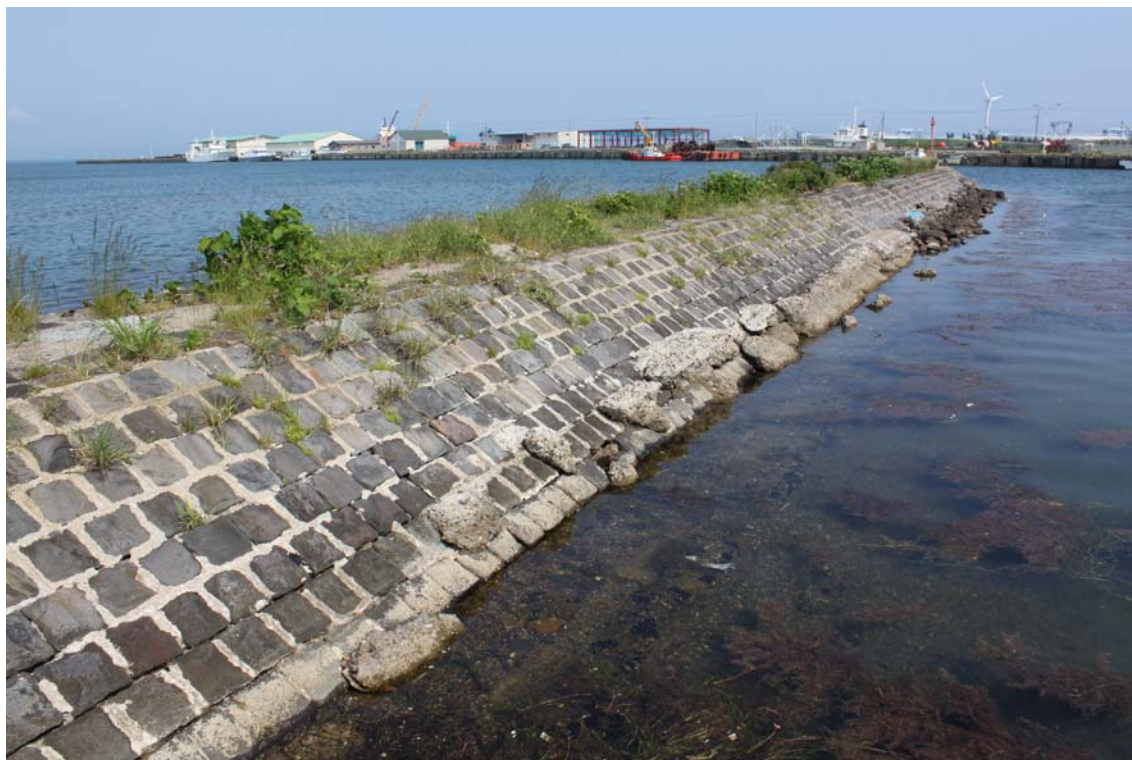
船川港第一船入場・第二船入場防波堤
