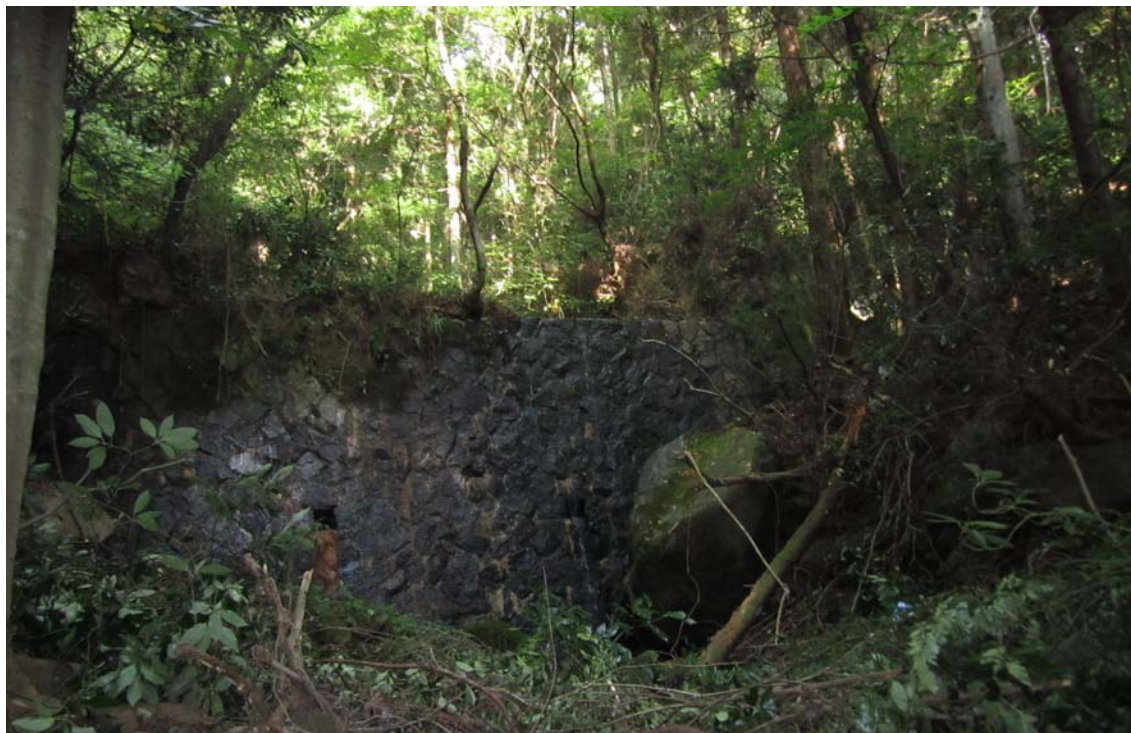
筑波山千寺川砂防堰堤群
