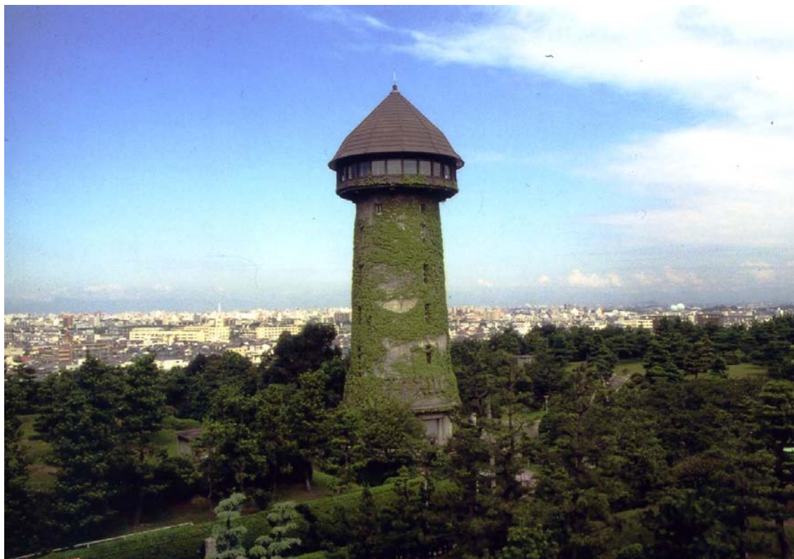
名古屋市旧第一ポンプ所と東山給水塔
