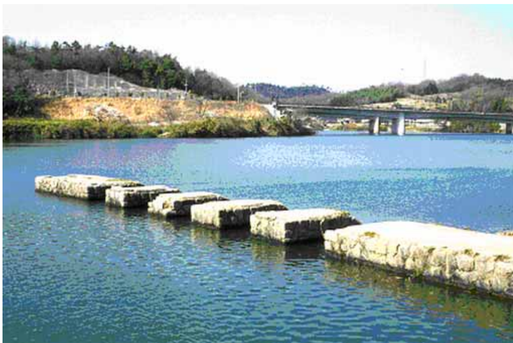
明治用水旧頭首工
