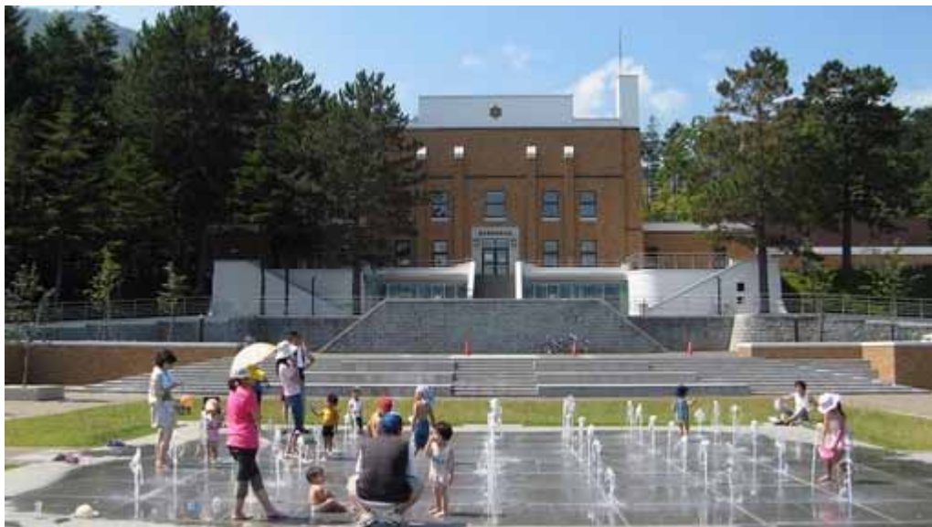
札幌市水道記念館（旧藻岩浄水場）
