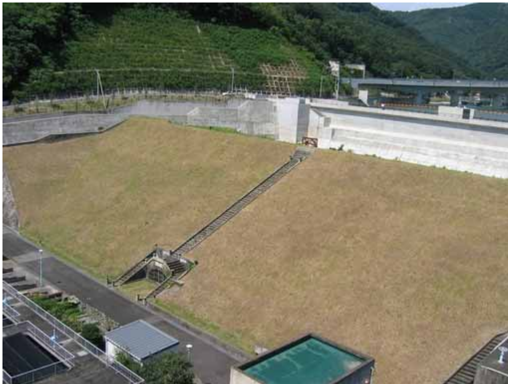
本河内高部堰堤
