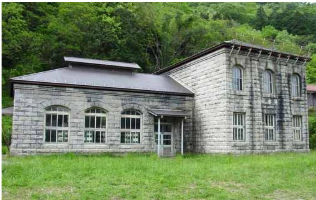
（旧）江尾発電所
