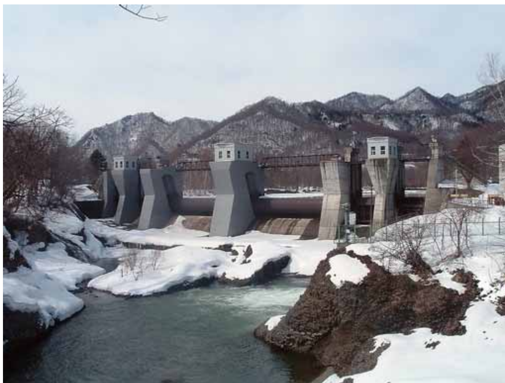
藻岩発電所・取水堰
