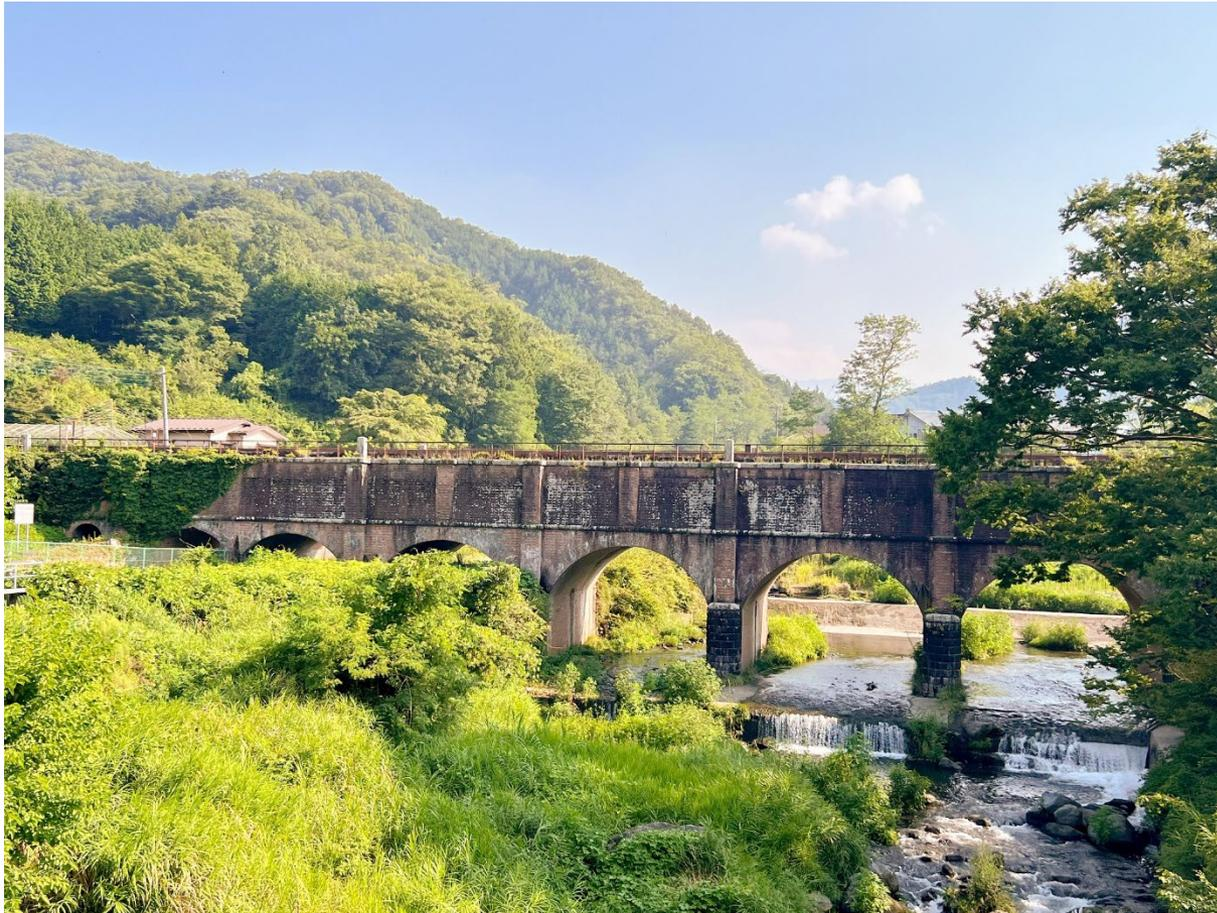
駒橋発電所落合水路橋は、希少な煉瓦造7連アーチの水路橋で、明治期の水主火従への電力政策転換を象徴する貴重な土木遺産です。
