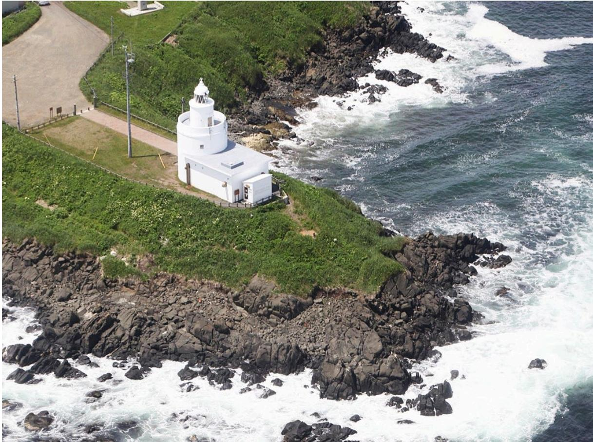
納沙布岬灯台は、北米航路の危険海域を示す船舶の指標として明治初期に設置され、のちに霧笛を併せ持つ方形・円形の複合RC構造に改修された灯台です。
