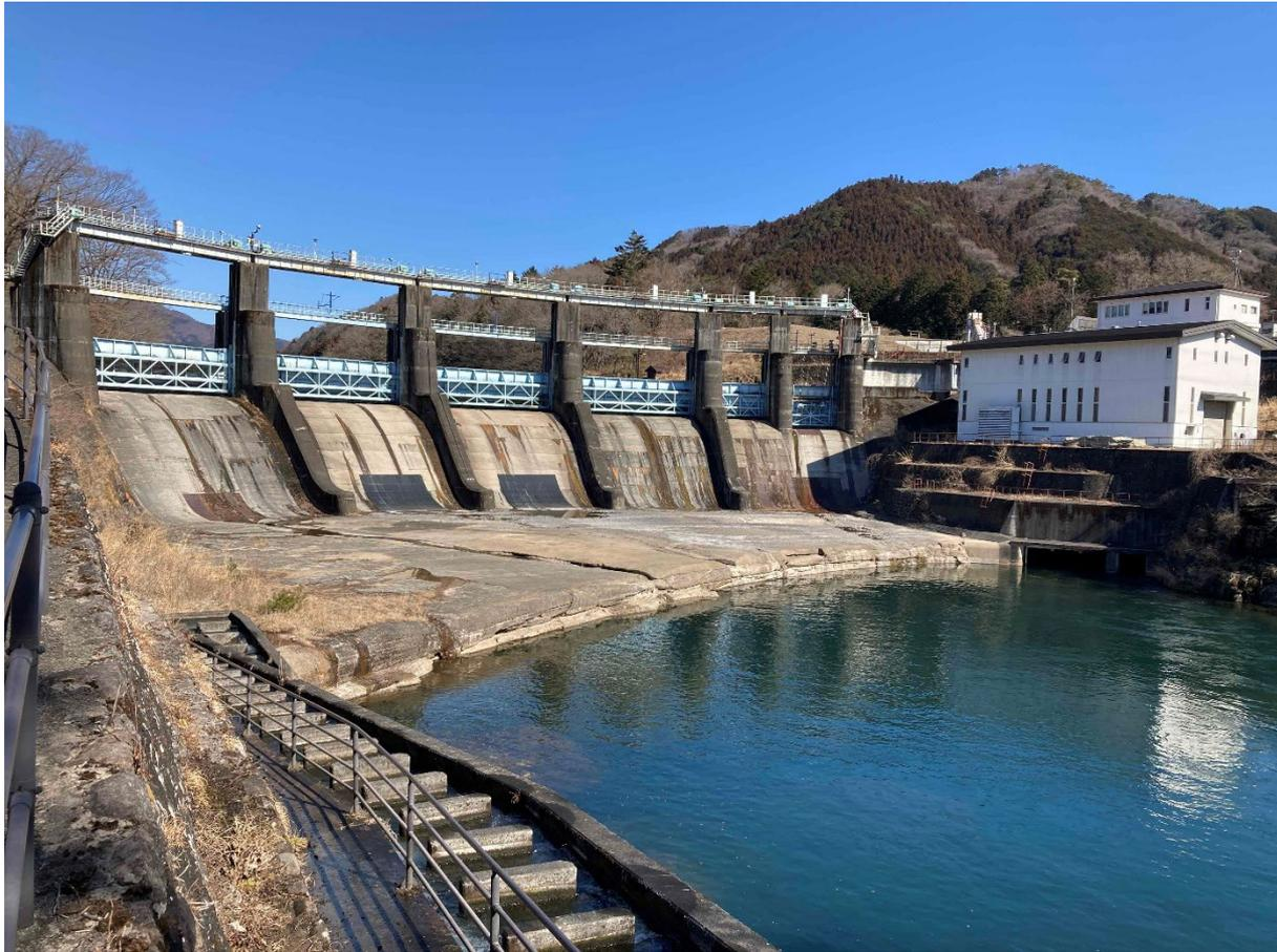
中岩ダムは、鬼怒川水力電気によって大正期に建設された曲線形重力式ダムの早期の事例で、滑らかな湾曲線が美しい土木遺産です。
