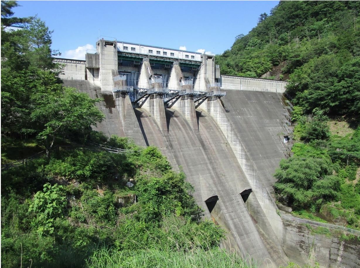
大野ダムは、わが国で初めて大口径放流管を備えた本格的な洪水調節ダムで、形状・意匠にも配慮された優れて先駆的な戦後土木遺産です。
