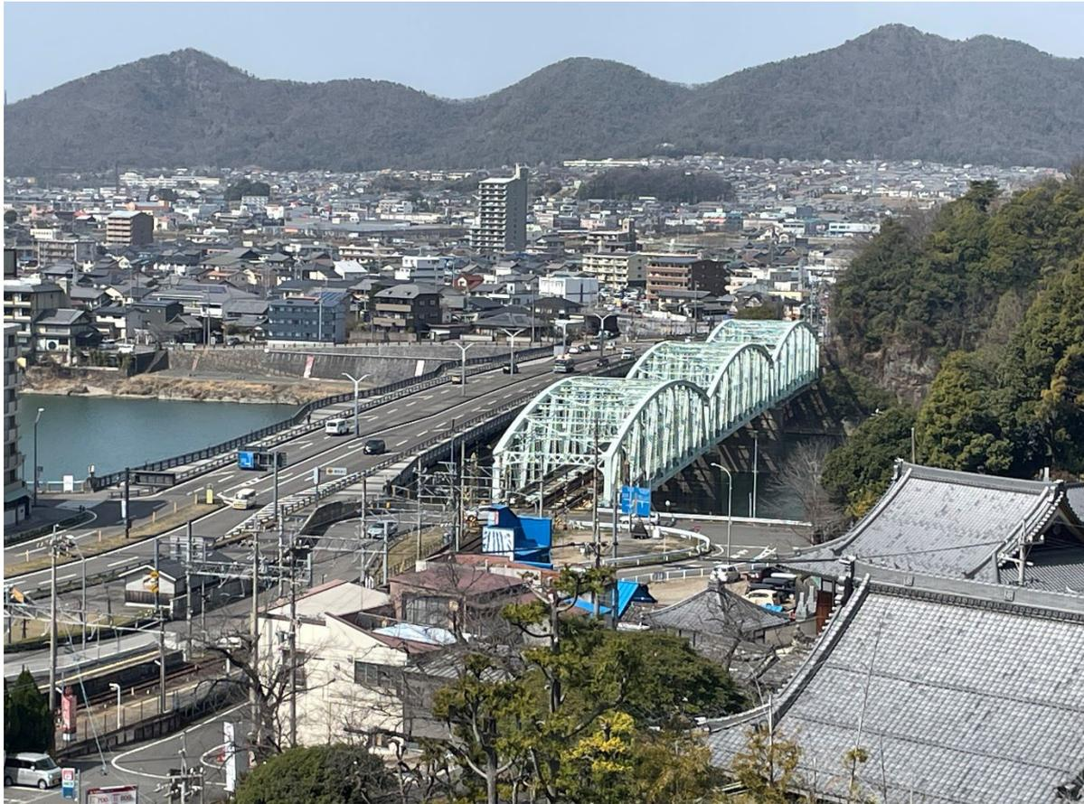
犬山橋は、大正時代に樺島正義が鉄道道路併用橋として設計し鉄道橋へ改修された、オベリスク様の親柱が残る3連の鋼ワーレントラス橋です。
