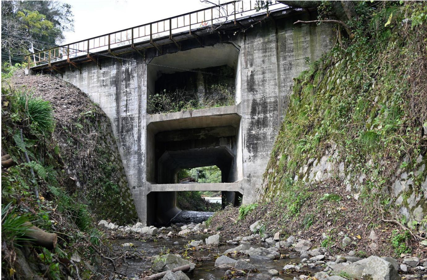
志谷川橋梁、日向川橋梁は、三江線でのみ採用された極めて珍しい目の字形鉄筋コンクリートラーメン橋です。
