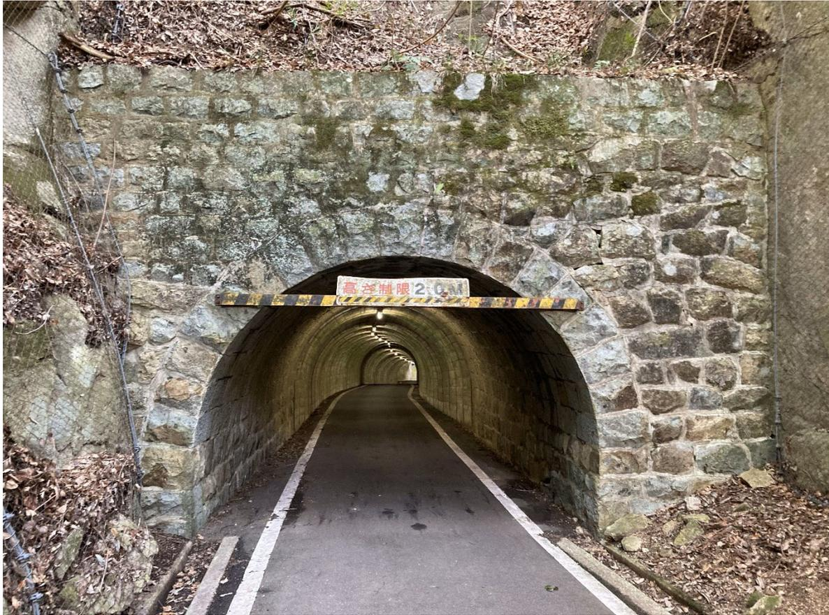
林田隧道は、摂津・丹波間の交通の難所を解消するため建設され、石ポータルを有する現役の道路隧道の中で日本最古の土木遺産です。
