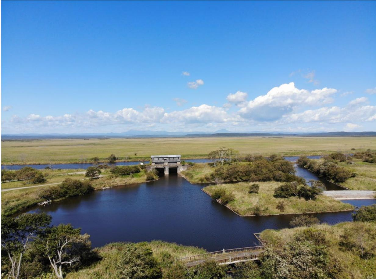
旧岩保木水門は、釧路の発展に寄与した新釧路川開削を象徴し、後年増築された木造上屋が特徴的な道内最古の鉄筋コンクリート造水門です。
