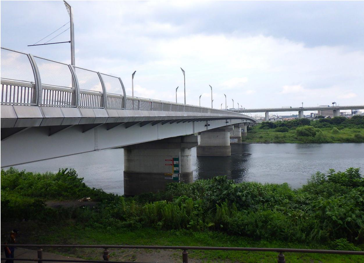
相模大橋は、国内で初めて、20t荷重で設計され、主桁の大半に高張力鋼を用いた橋梁で、我が国の橋梁技術発展の礎となった貴重な土木遺産です。
