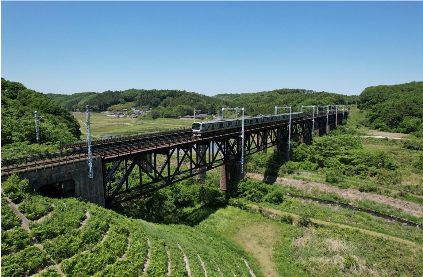
黒川橋梁(上り線)は、近代の鉄道技術を伝える貴重な鋼ワーレントラス橋で、重厚感漂う壮大な石張り橋脚が連続する圧倒的スケールの優美な鉄道橋梁です。
