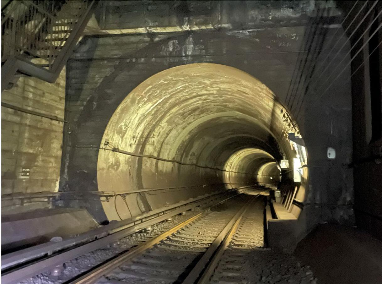
覚王山ずい道は、都市部における国内初の開放型手掘り式シールド工法、円形断面シールドと鉄筋コンクリート製セグメントを採用した地下鉄トンネルです。
