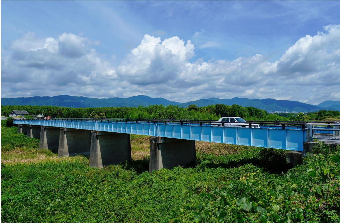
瀬詰橋は、吉野川支流の川田川に架かる旧道の橋で、大正時代の中路式鋼鈹桁橋は希少であり、左岸に建設当時の親柱が現存する貴重な土木遺産です。
