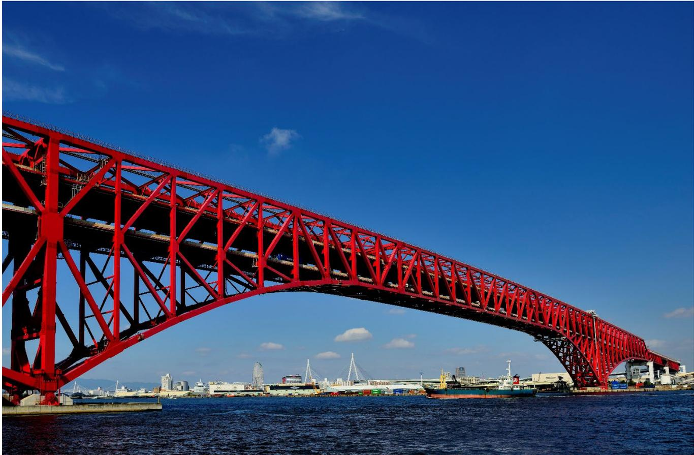
港大橋は、規模、材料、工法ともに我が国のトラス橋の到達点を示した、中央径間長としては日本最長、世界第3位のゲルバートラス橋です。
