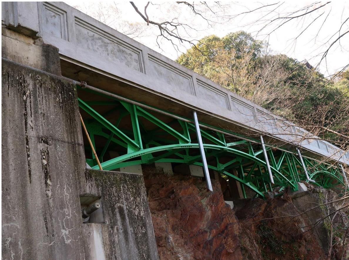
彩雲橋は、昭和初期の犬山城附近の観光開発の中で木曾川へ流れ込む郷瀬川上に架けられた鉄道レールを用いた瀟洒な2連アーチ橋です。
