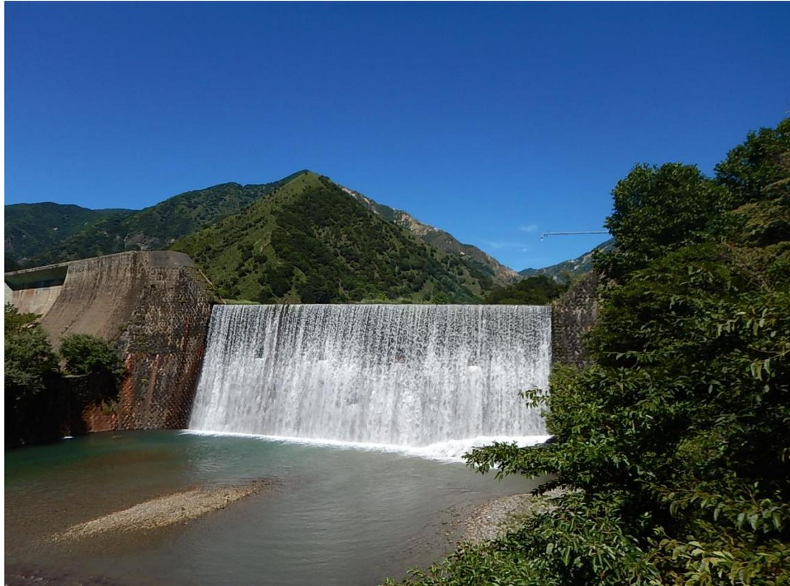
渡良瀬川上流域足尾の砂防堰堤群は、大規模な土石流災害の軽減・抑止を目的とした本邦最大級施設を含む砂防堰堤群で、環境を視点に未来への思考を誘う重厚な土木遺産です。
