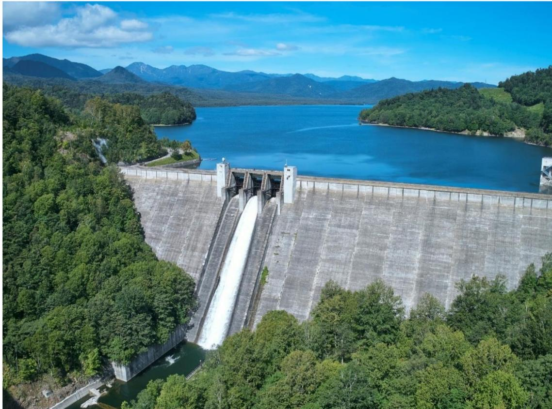
糠平ダムは、当時最高水準の国産大型機械採用や前例のない蒸気養生により、寒地での短期施工を実現した北海道内の電力安定を支える重力式ダムです。
