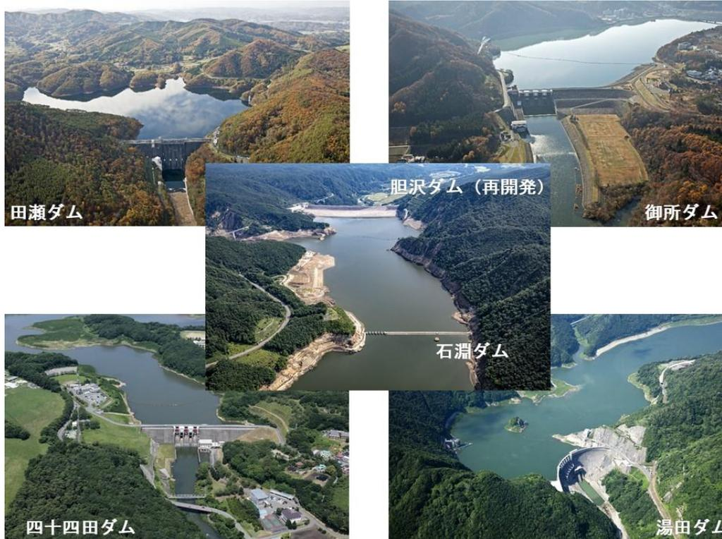
北上川上流総合開発ダム群 五大ダムは、北上川流域の治水を最大の目的にしながら、発電・灌漑用水・上水などの機能を併せた多目的ダム群として地域を支える土木構造物群です。
