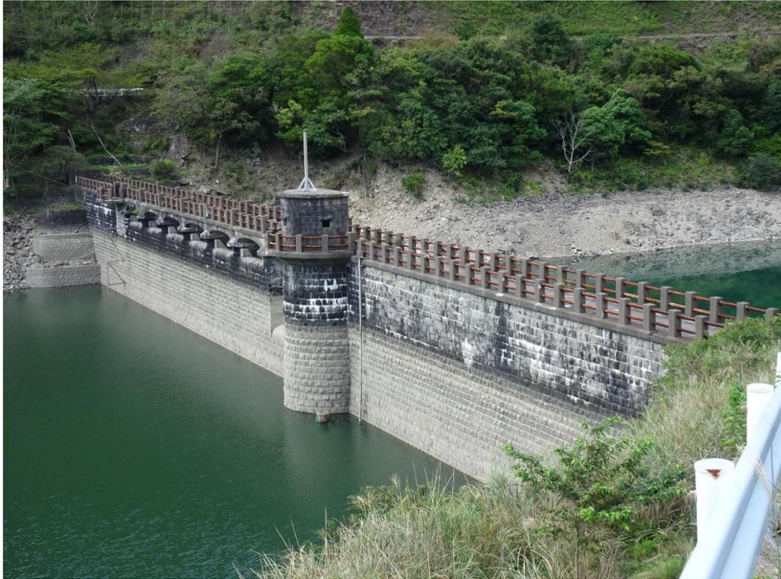
旧成相池堰堤は、渇水時の農業用水確保のため建造された粗石モルタル造の重力式ダムで、先人の水確保の努力を後世に伝える貴重な土木遺産です。
