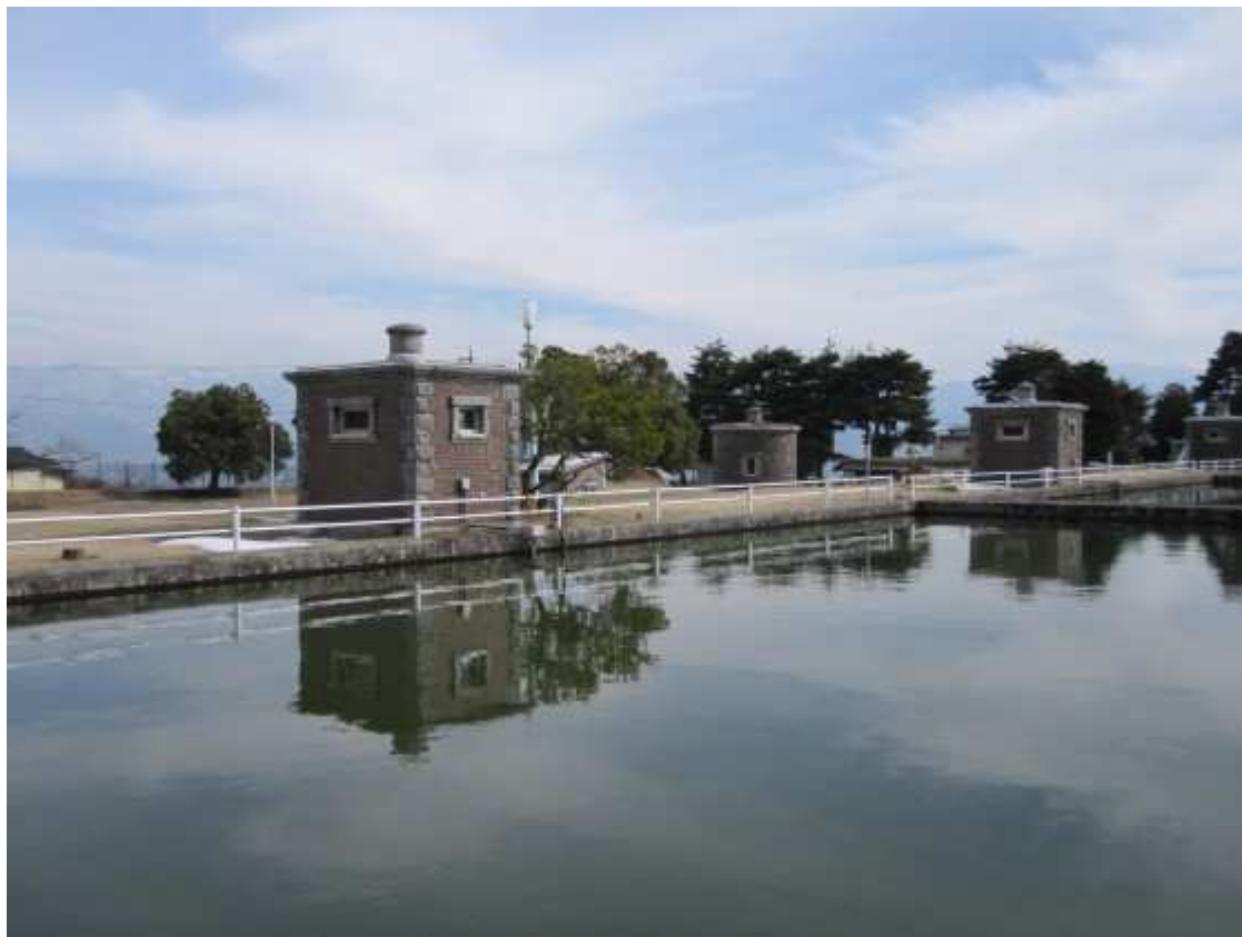
往生地浄水場
