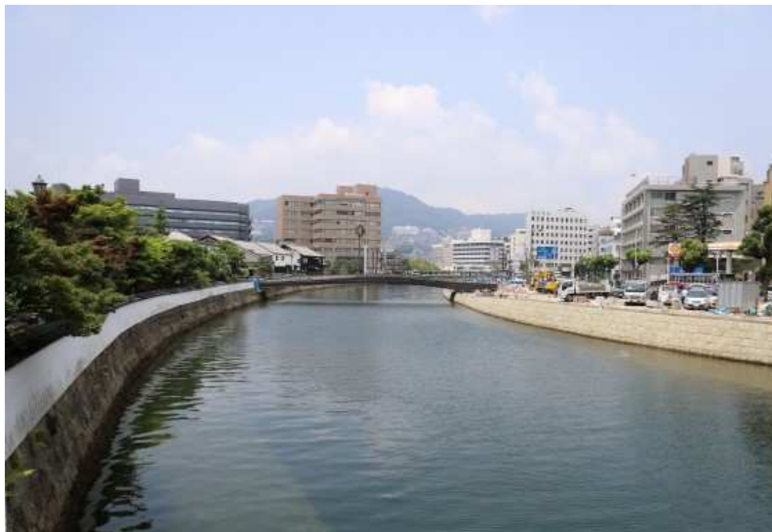
中島川変流部護岸
