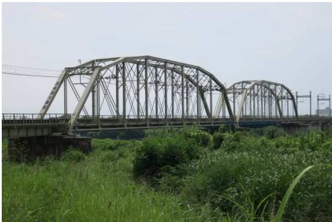
東武鉄道渡良瀬川橋梁・砥川橋梁
