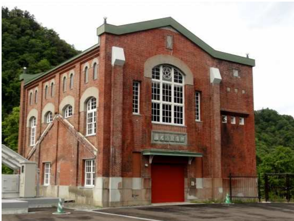
滝の上発電所施設群
