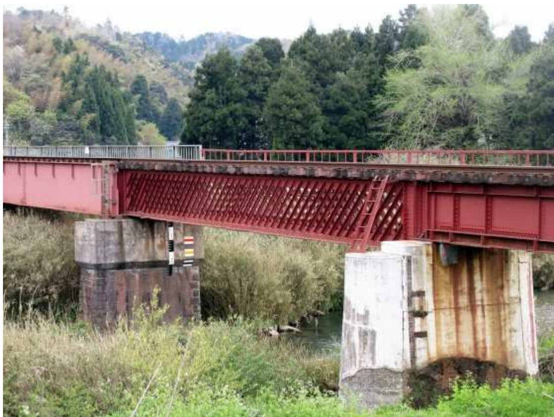
竹野川橋りょう ・ 田君川橋りょう
