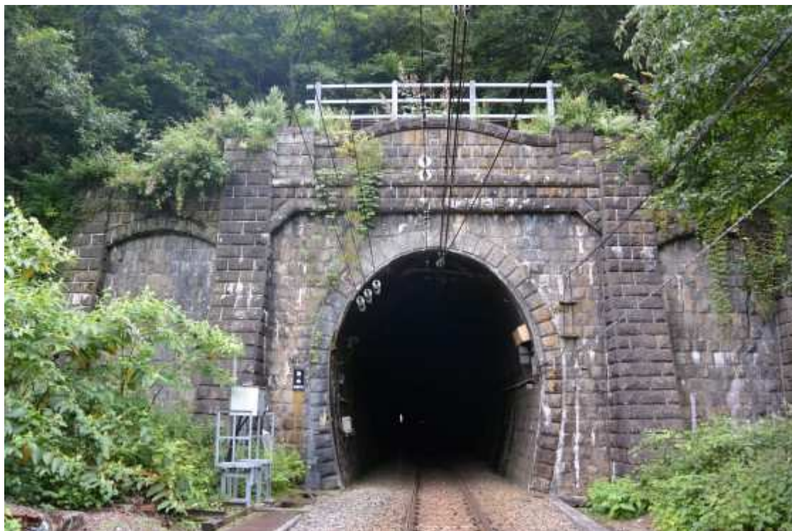
J R 上越線清水トンネル関連施設群
