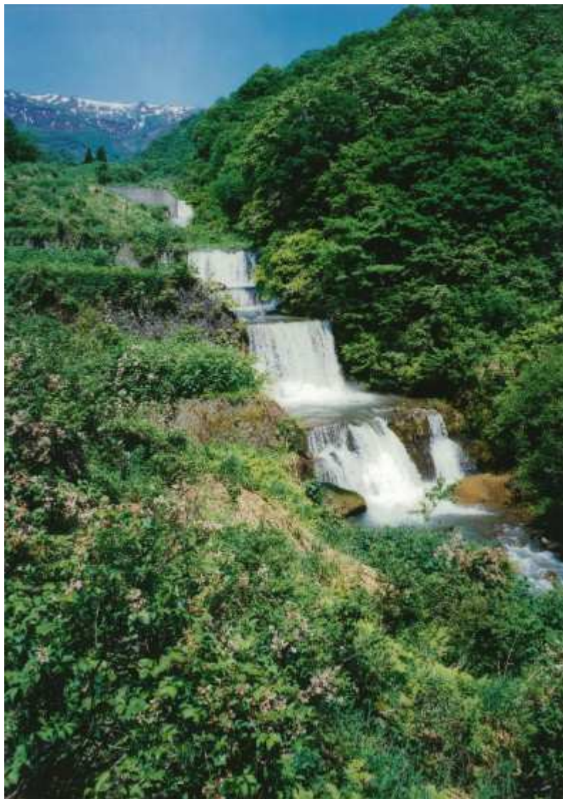
万内川砂防堰堤群・日影沢床固工群
