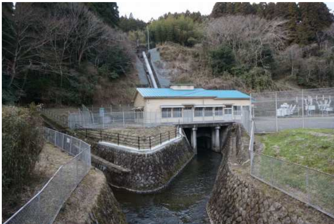
里川水系水力発電所群
