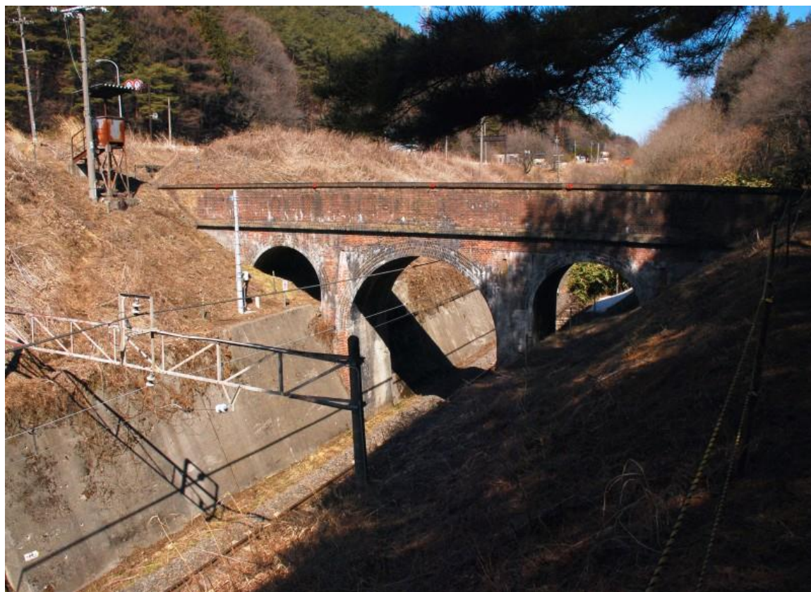
蔵造川水路橋
