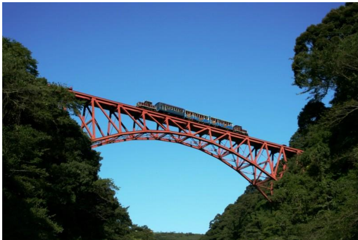
第一白川橋梁
