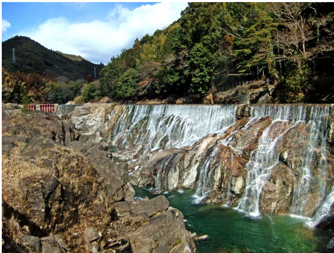
長篠発電所の堰堤と取水路
