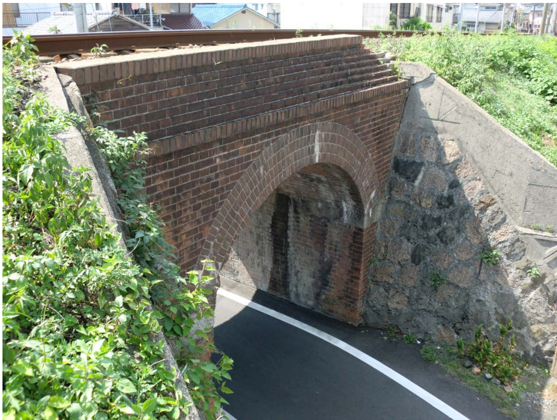
煉瓦橋（横河原線・第 26 号溝橋）
