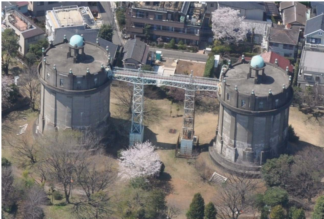
駒沢給水所（配水塔・配水ポンプ所）
