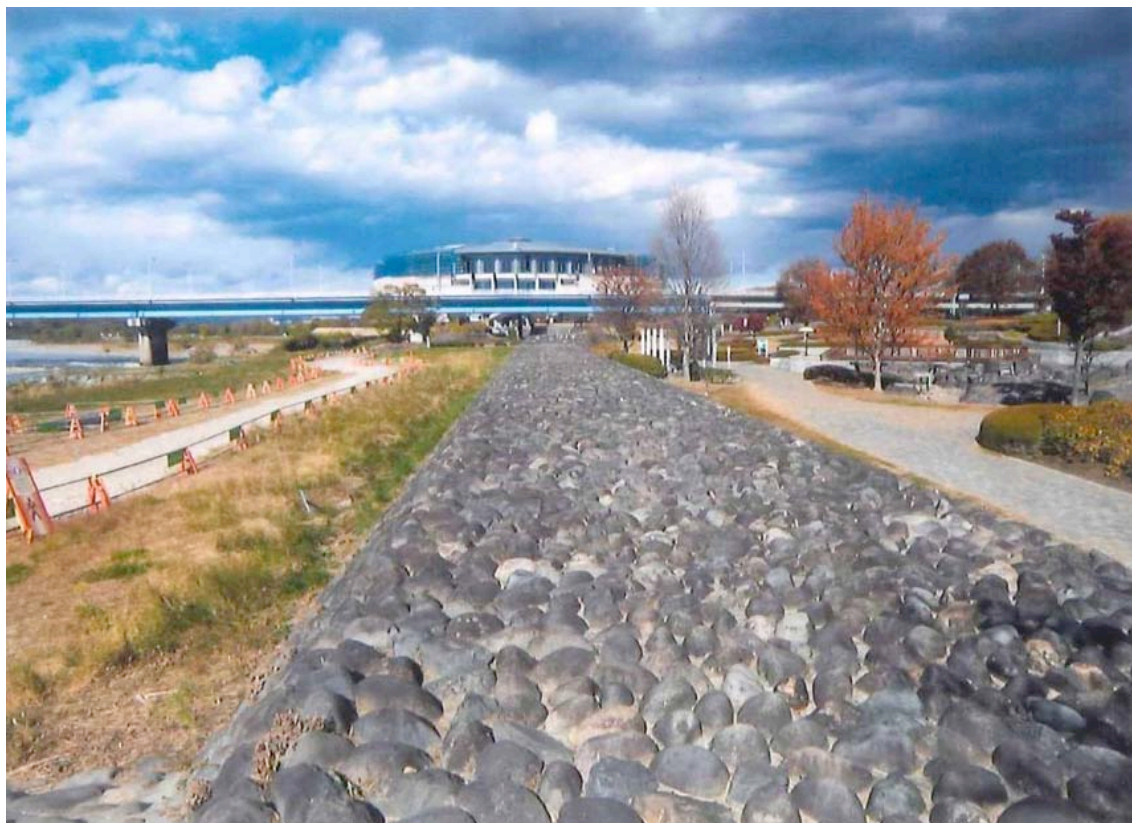
前橋地先の利根川の護岸と水制工
