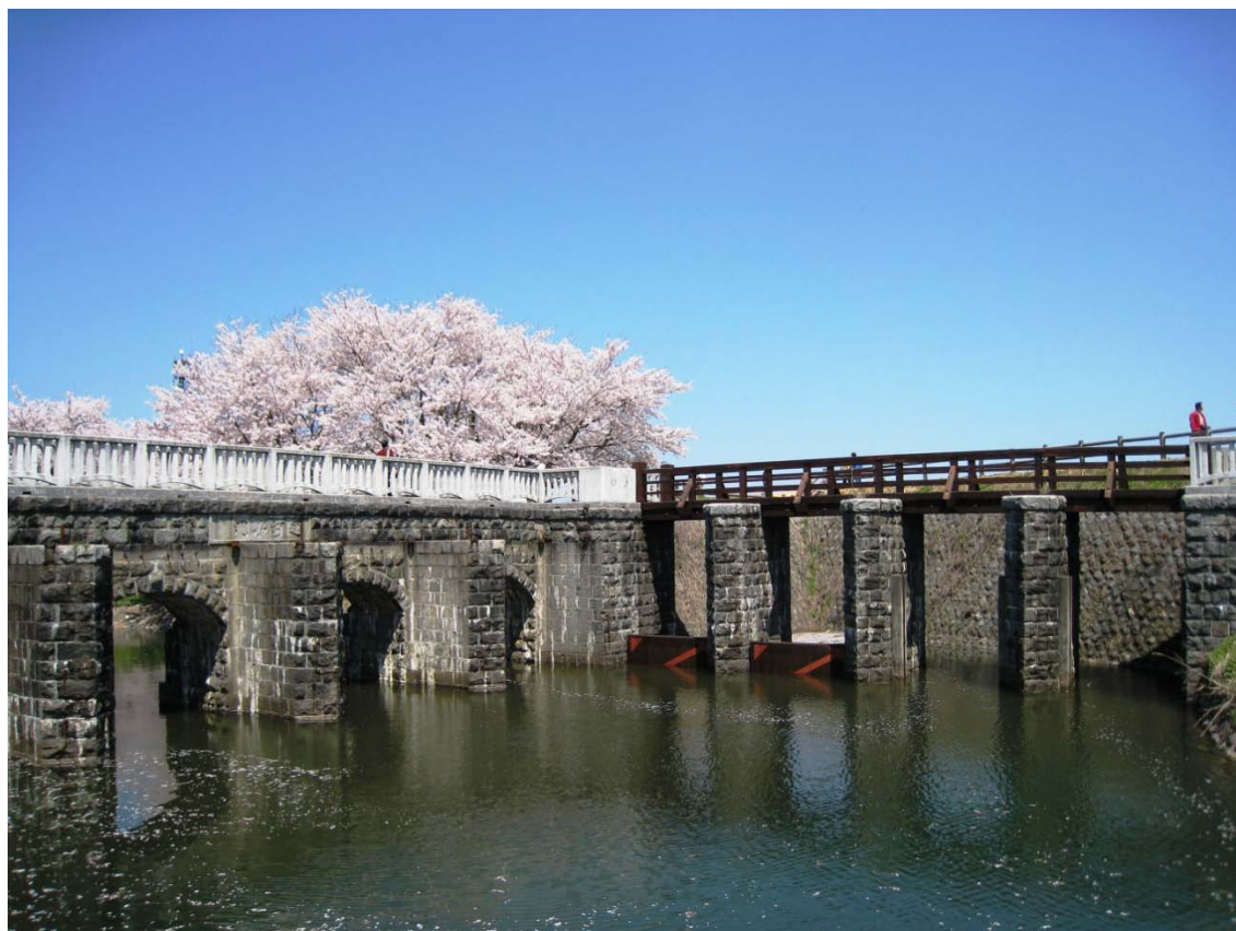
加治川運河水門、土砂吐水門
