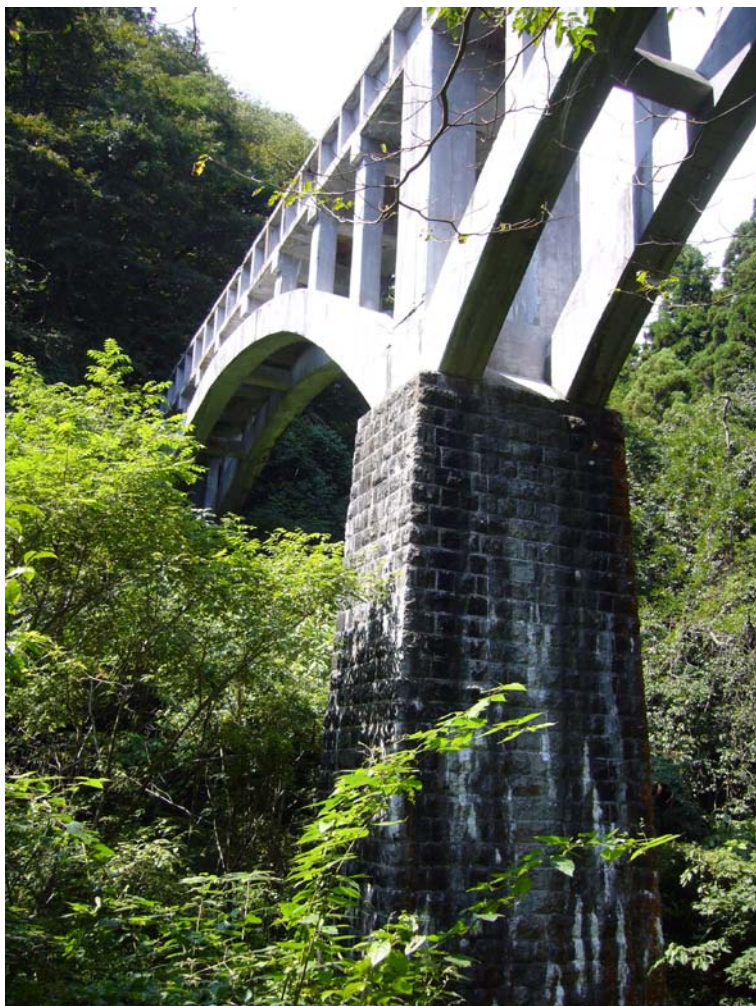
花貫川第一発電所 第三号水路橋
