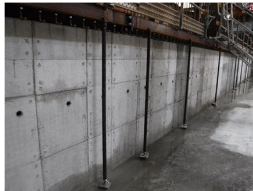
コンクリート型枠
