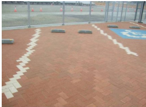
舗装コンクリートブロック
