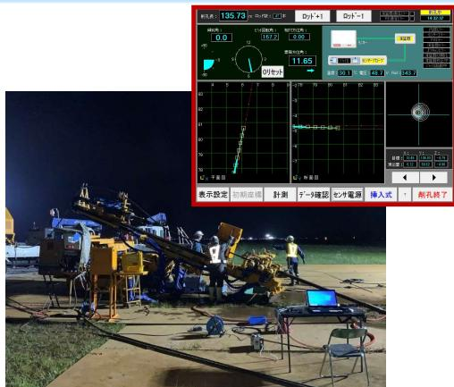
削孔軌跡の計測データ
