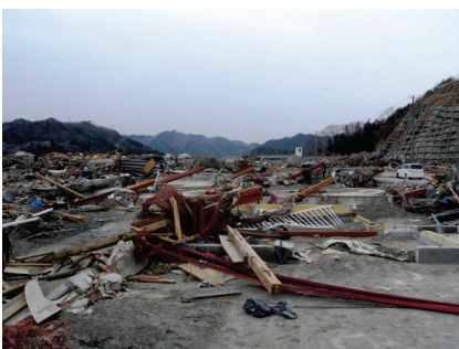
岩手県大槌町の鉄骨造の建物被害 (2011年4月8日撮影)
