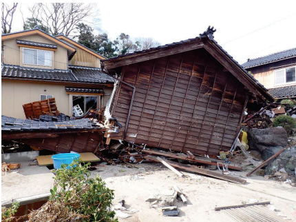
地震で倒壊した木造建物が津波で流出している（能登町白丸）
