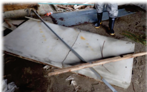
鉄骨骨組に充填された自重式コンクリートブロック壁が転倒している
