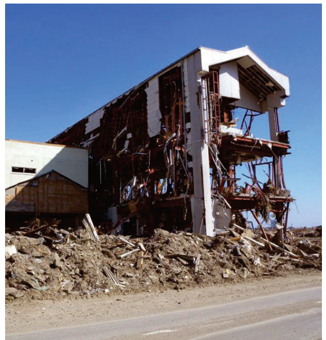
岩手県陸前高田市の鉄骨造の建物 (2011年4月6日撮影)
