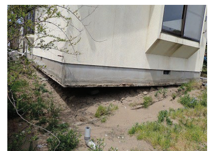
液状化・側方流動に強い家屋
