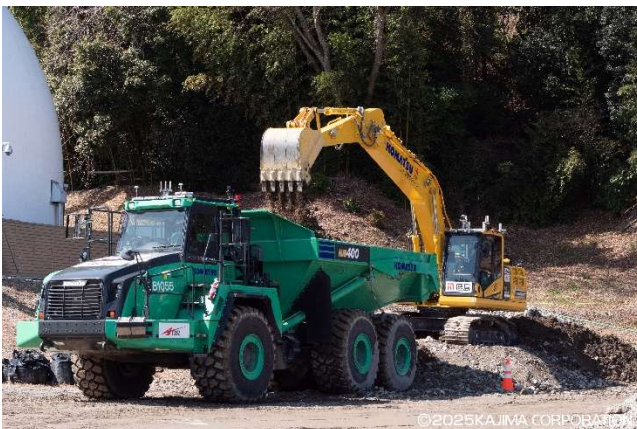
バックハウ、アータィキュ レートダンプの自動化施工
