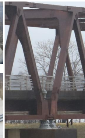
(d) The bearing pin unfastened.
