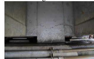
(d) The End of Girder.
