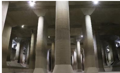
こたえ「 放水路 (ほうすいろ) 」
