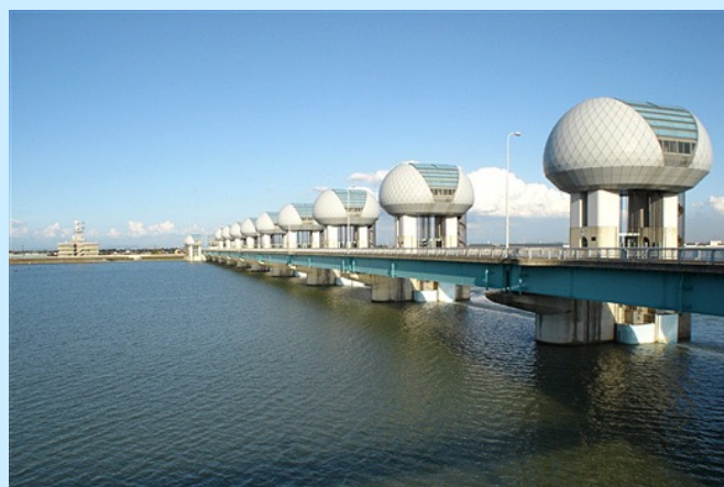
長良川河口堰 (提供:(一財)日本ダム協会)
