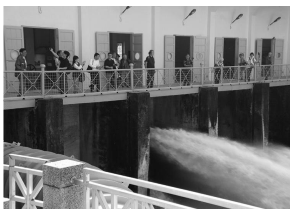
写真2 旧放水路からの特別放水
