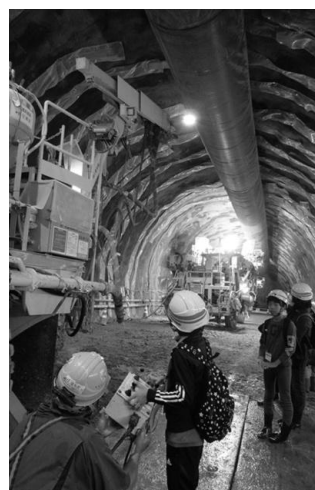
夏休み親子見学会の様子（呉トンネル建設現場）
