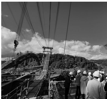
市民見学会(長野県橋梁建設現場)
