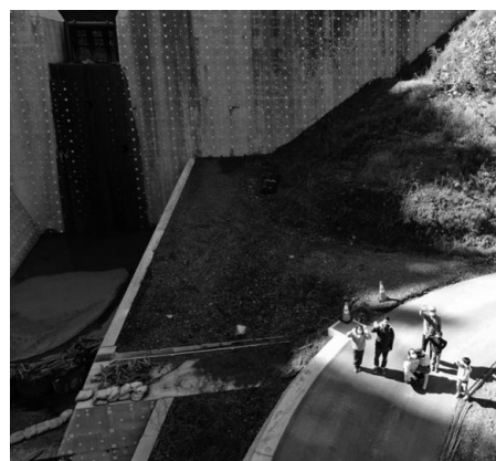
親子ふれあい見学会(岐阜県 砂防堰堤建設現場)
