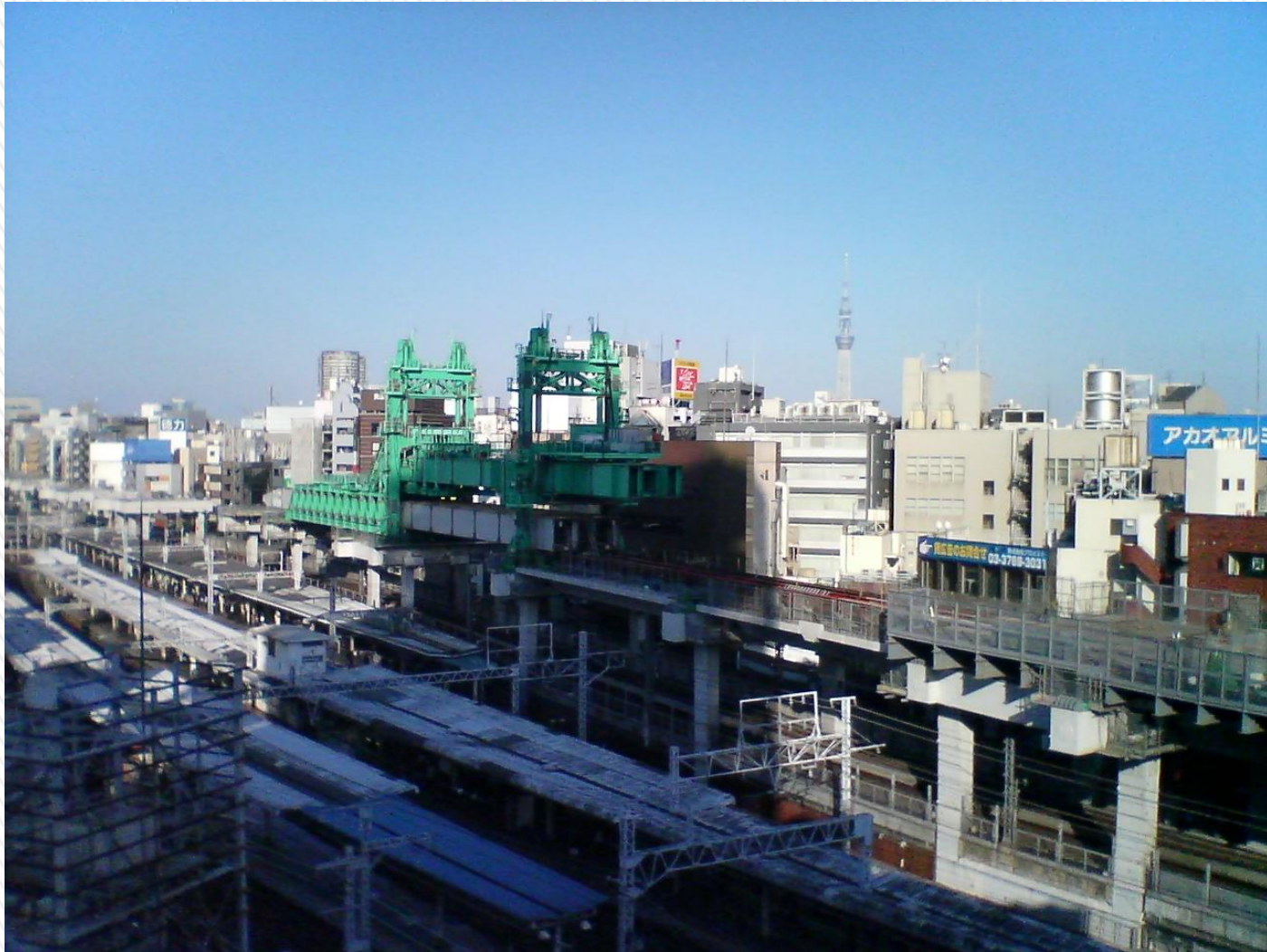
東北縦貫線 現場
