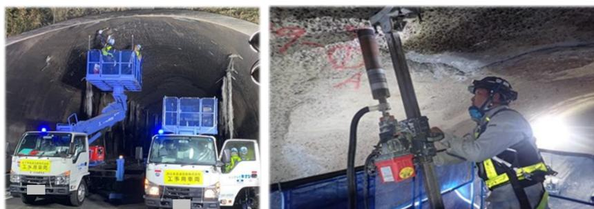
写真 4. 2. 11. 2 たたき検査状況（左）およびコア削孔状況（右）<sup>1)</sup>
