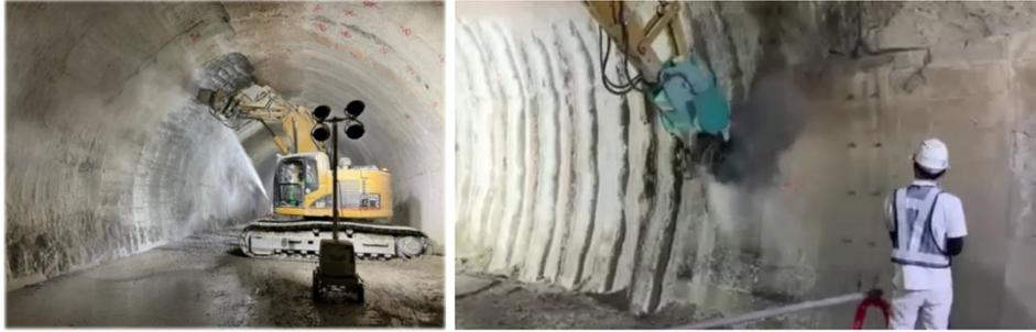
(a) 覆工コンクリート損傷部の除去作業状況
