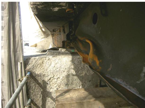
(a) 鋼主桁の損傷状況
