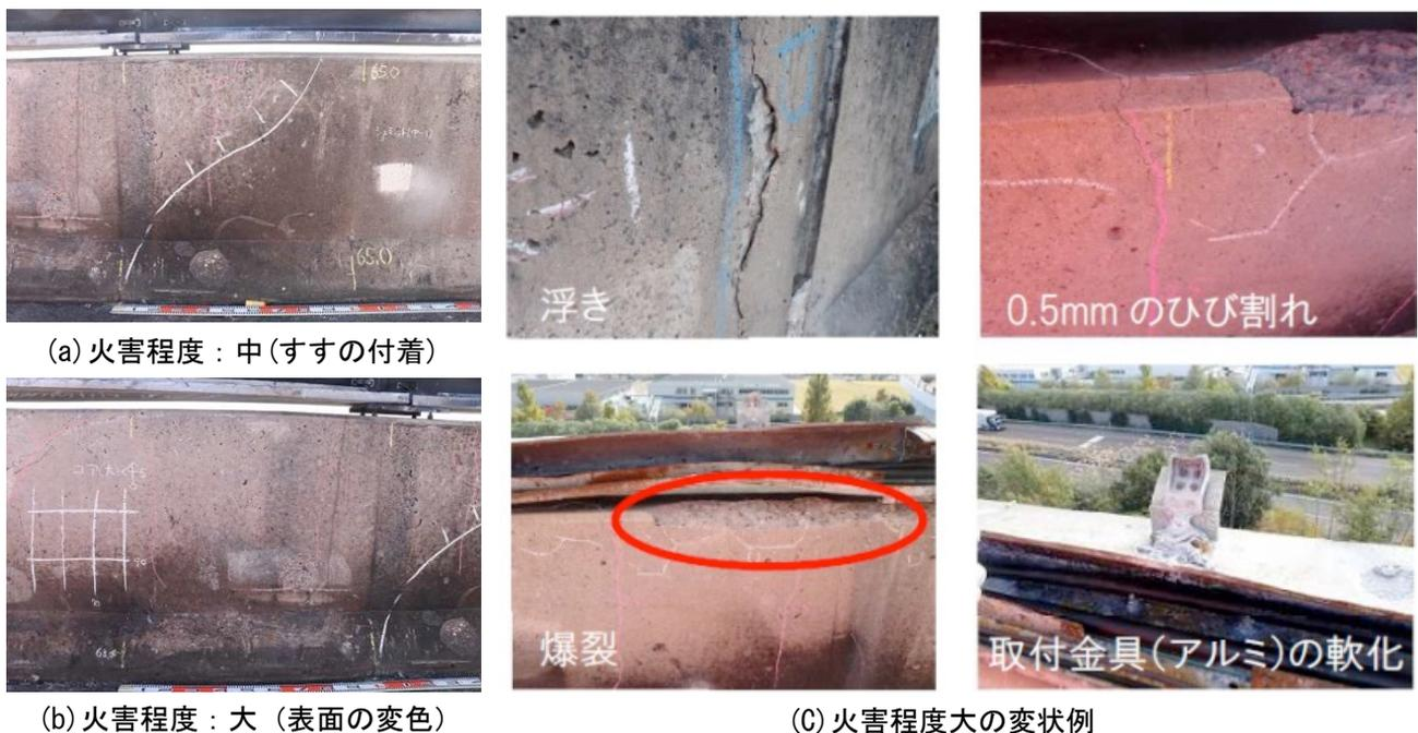
写真4.2.10.1 火災による劣化状況
