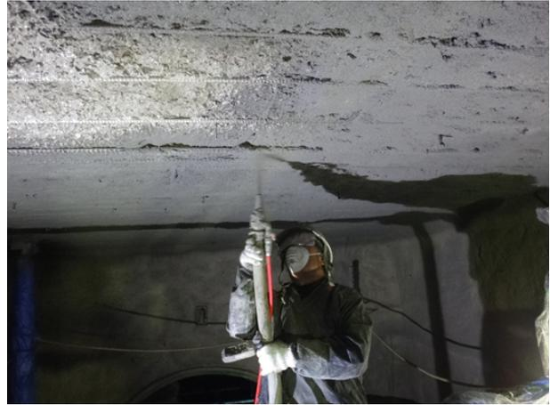
(b) 天井部施工状況（吹付け工法）
