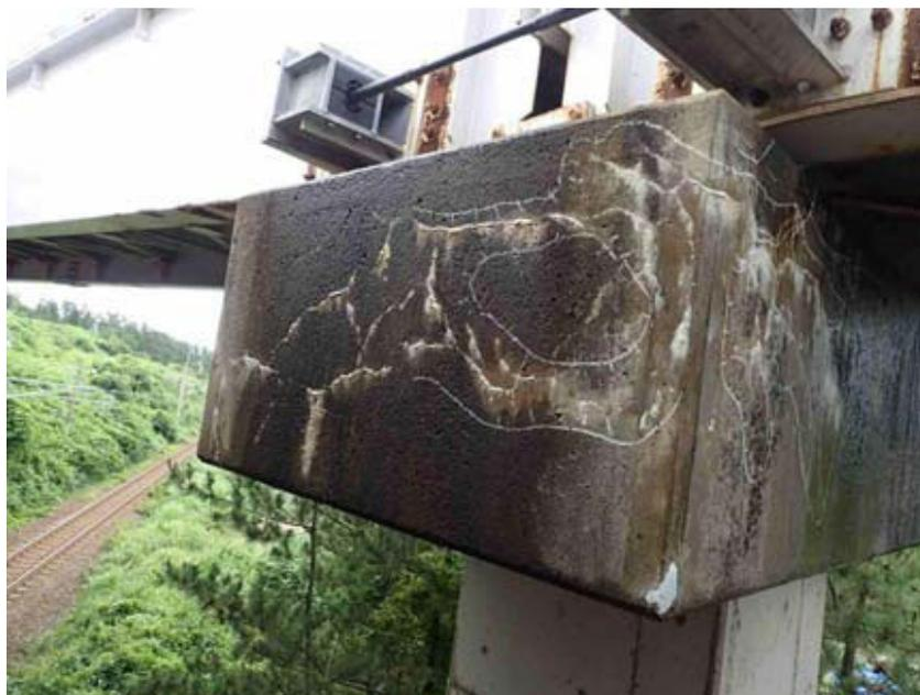
写真 3.2.2.3 海岸線近くの側道橋の ASR の事例 (1991 年 (平成 3 年) 供用)
