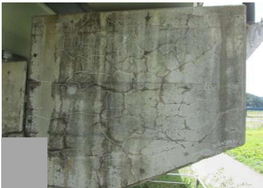
写真 3.2.2.4 内陸部の側道橋の ASR の事例 (1993 年 (平成 6 年) 供用)
