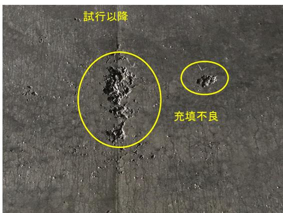
写真 2.4.5 試行後に施工した箇所の不具合例 2
