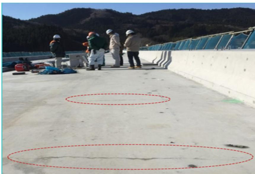
写真 4.1.1 高耐久床版に発生した橋軸直角方向のひび割れ
