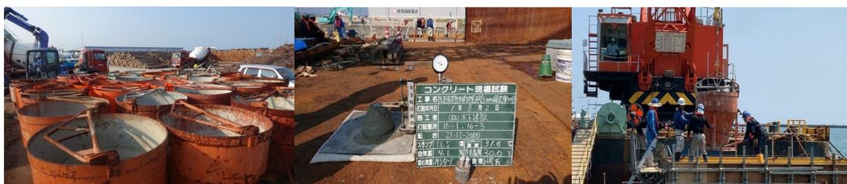
写真 3.1.1 KSP を用いたコンクリートの運搬・施工状況
