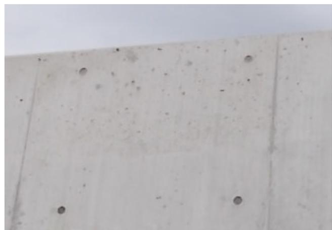
図 2.6.3 表面気泡箇所の拡大 (事例3)
