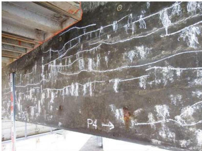
写真 3.2.2.2 PC 箱桁の ASR の事例(1986 年(昭和 59 年)供用)
