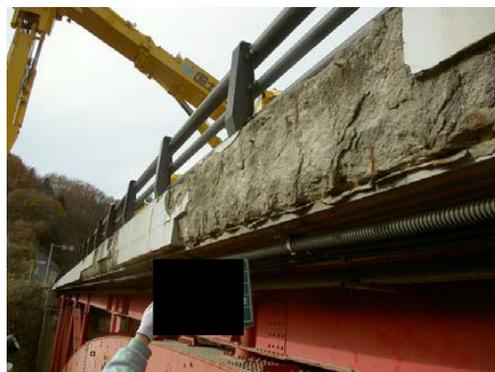
平成16年に剥離・うきが確認されたが平成21年に剥離範囲が拡大し、平成26年には鉄筋露出も確認された。
