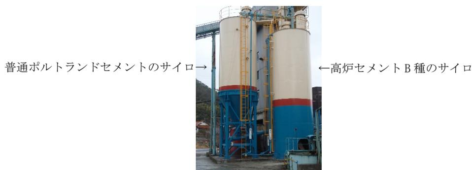
写真 3.1.2 生コンクリート工場における普通セメントと高炉セメントのサイロ<sup>3)</sup>
