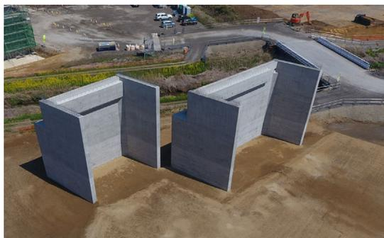
写真-3 RC橋台の完成後の概観
