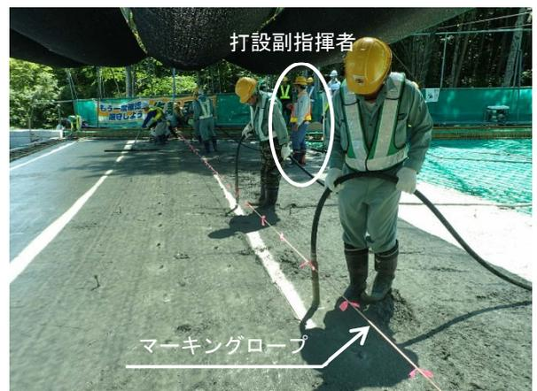
写真-3 床版コンクリート打込み状況
