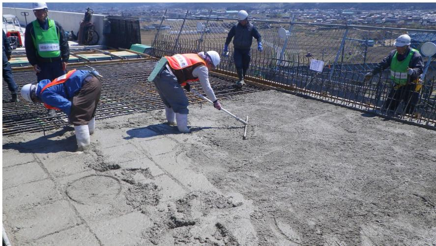
(a) 締固め直後の床版天端高さを調整している状況（表面が乱れる）
