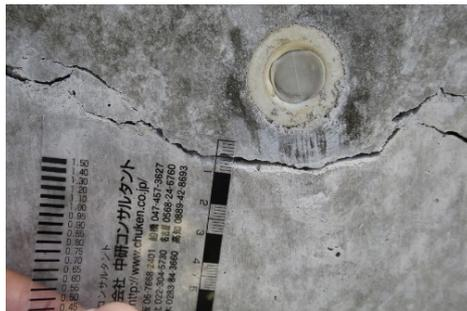
写真-2.7.3 沈下びびわれ
