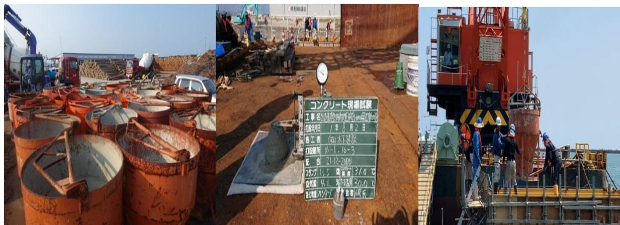
写真-1 KSPを用いたコンクリートの運搬・施工状況
