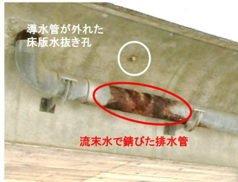
導水管が外れた床版水抜き孔
