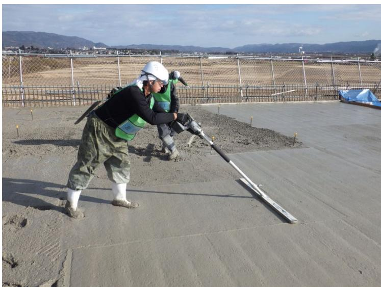
図 2.2.2.5 修正配合による表面仕上げ状況例
