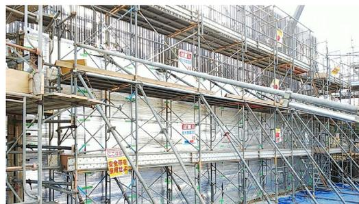
写真-1 遮熱シートの設置状況(脱型前)
