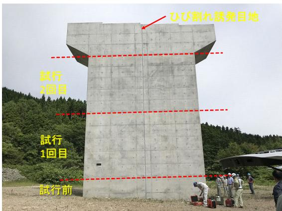
写真 2.4.7 橋脚コンクリートの試行箇所
