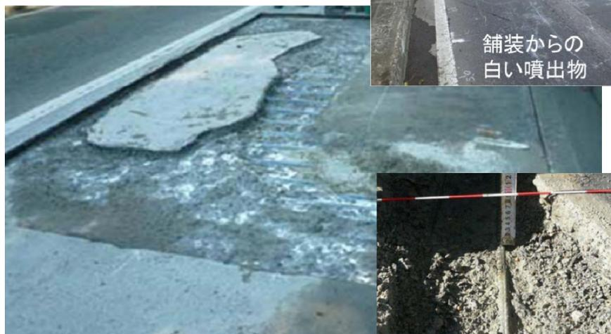
舗装撤去後、脆弱なコンクリートを除去した状態
