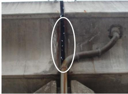
PC橋の伸縮装置からの漏水による塩害
