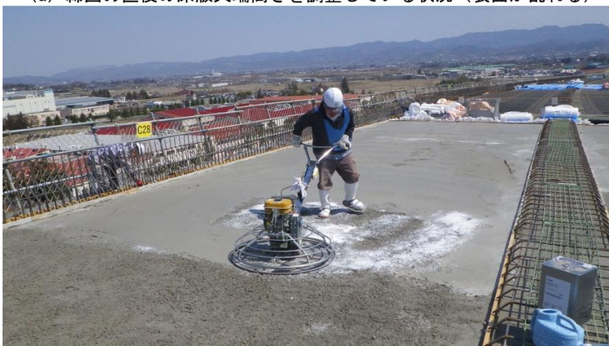
(b) 仕上げ補助剤を標準使用量の 3 倍使い機械仕上げしている状況
