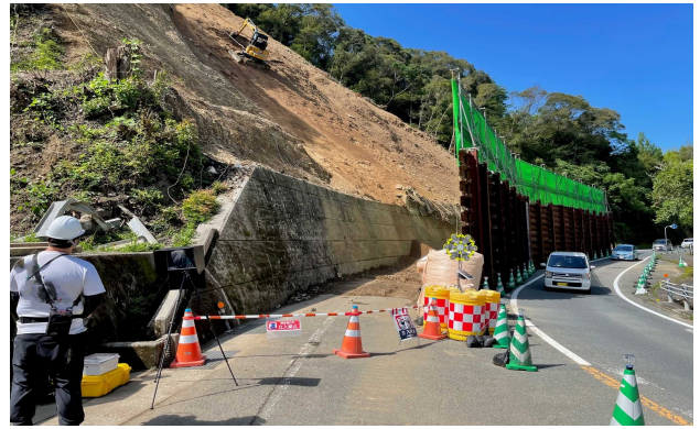
写真-4 崩土除去・法面整形施工状況
