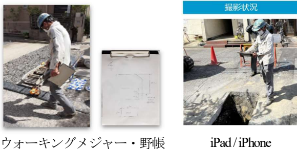
図-1 配管状況の記録（左：従来，右：現在 2) ）
