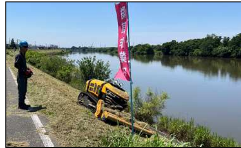
写真-1 遠隔操作草刈り機の遠隔施工状況
