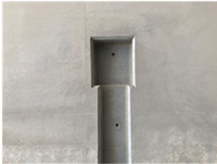
図-12 箱抜き箇所の状況
