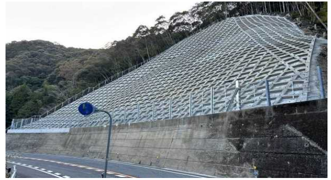
写真-6 完成した国道法面の状況
