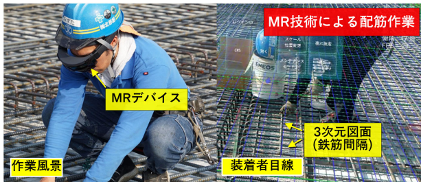
図-12 3D重量システムによる床版配筋施工
