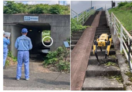
写真5 ボックスカルバート内におけるSpotの操作状況と階段昇降状況
