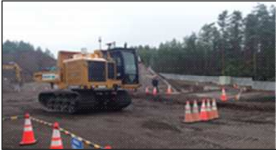
写真-4 無人キャリアダンプ自動運搬状況
