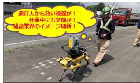
写真4 ロボティックスを活用した測量
