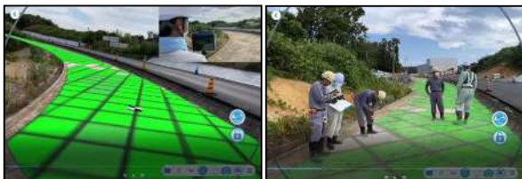
写真-6 AR技術を用いた出来形管理（イメージ） 1)
