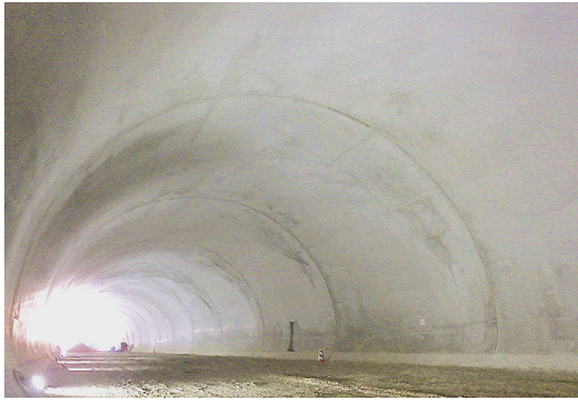
図-11 覆工コンクリートの外観
