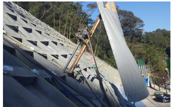
写真-5 鉄筋挿入施工状況
