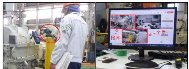
写真-7 遠隔臨場による段階確認状況
