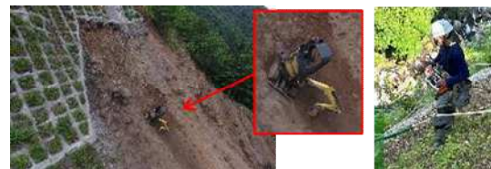
写真-2 セーフティクライマーの遠隔施工状況
