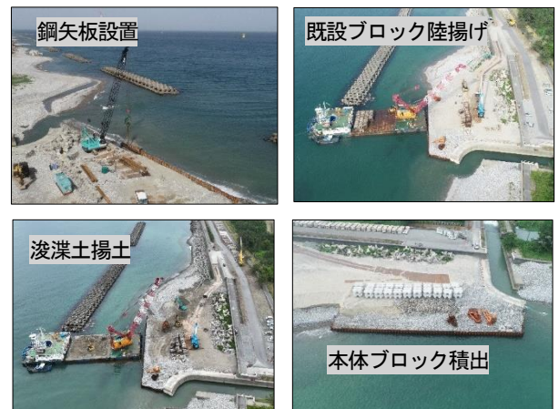
写真-6 仮設積出基地使用状況
