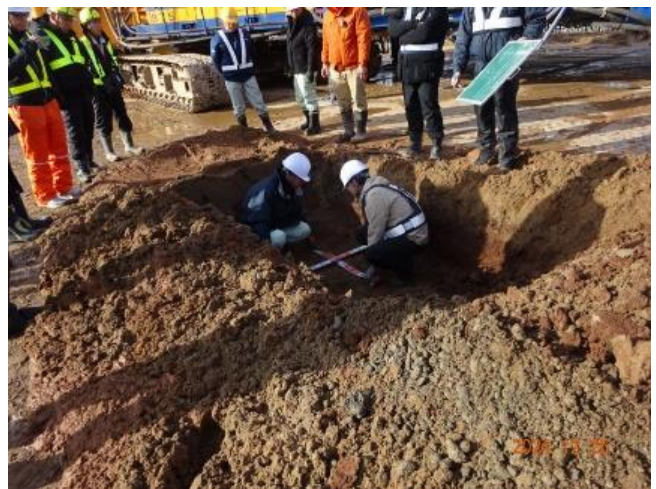
図-5 従来の掘り起こしでの出来形管理 (サンドコンパクションパイル工)
