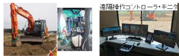
写真-3 バックホウの遠隔施工状況
