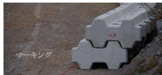
図-5 マーキング及びブロック設置状況
