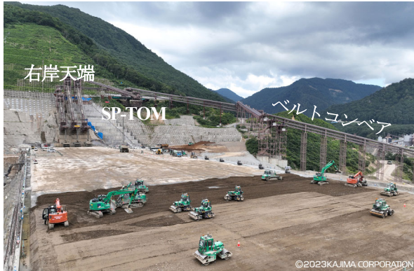
写真-1 自動化施工全景
