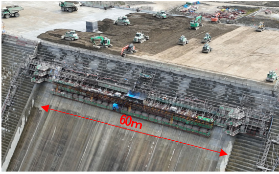
写真4 自動スライド型枠運用範囲
