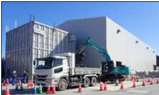
写真-5 自動バックホウ積込状況
