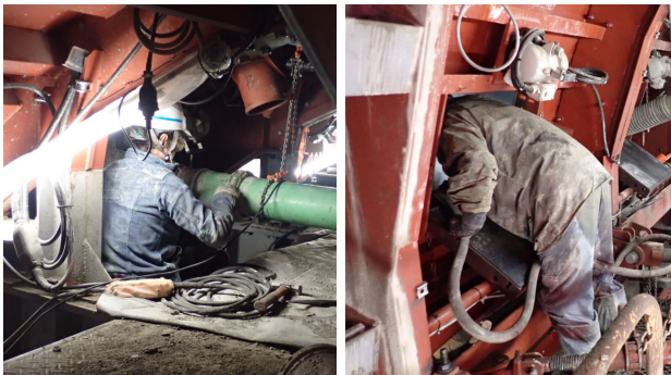
図-3 セントル内の狭隘空間での作業
