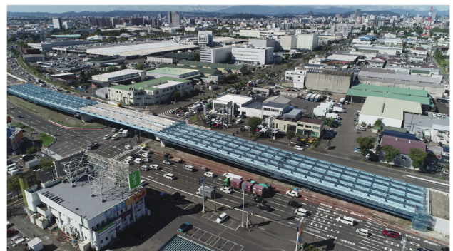
図-2 箱堤高架橋架設完了写真
