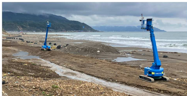
図-8 俯瞰カメラ用高所作業車配置状況
