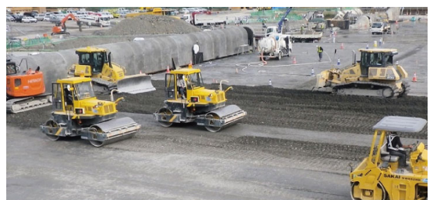
写真-1 盛土締固め転圧作業の様子
