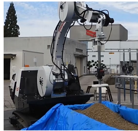
図7 電動重機による杭型センサポッドの設置
