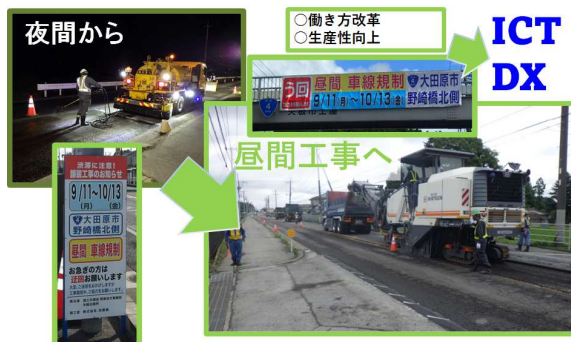
写真2 舗装メンテナンス工事を夜間から昼間へ
