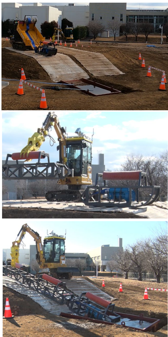
図8 小型油圧ショベルによる排水ポンプの設置動作
